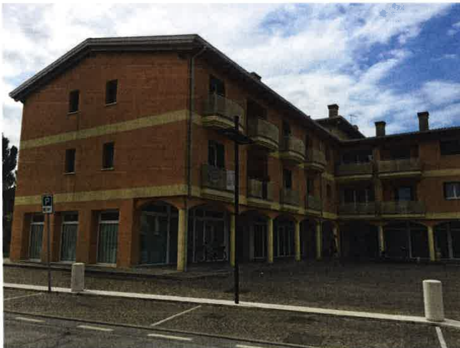
_foto generali del complesso edilizio
