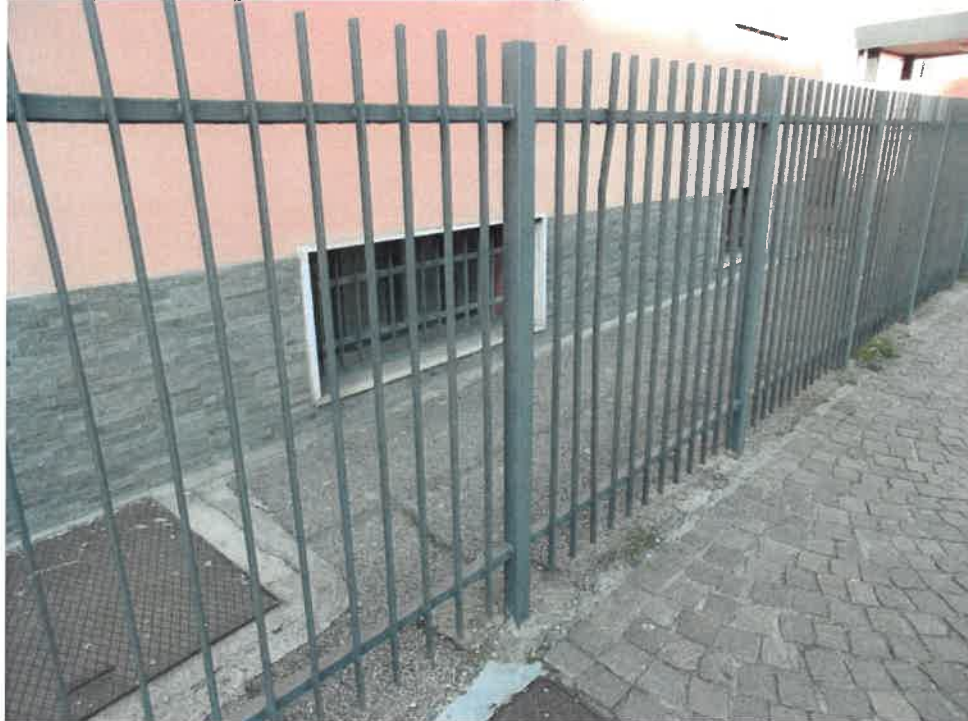
Foto 14: vista esterna finestra zona pranzo
