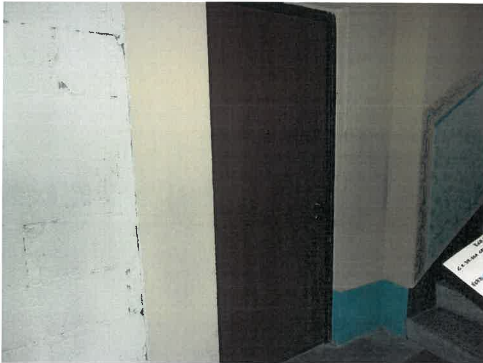
Foto 2: ingresso da corridoio condominiale al piano interrato
