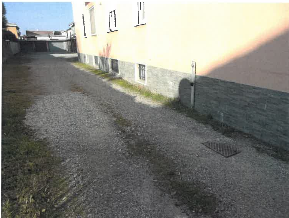
Foto 13: vista esterna delle finestre (lato lungo)
