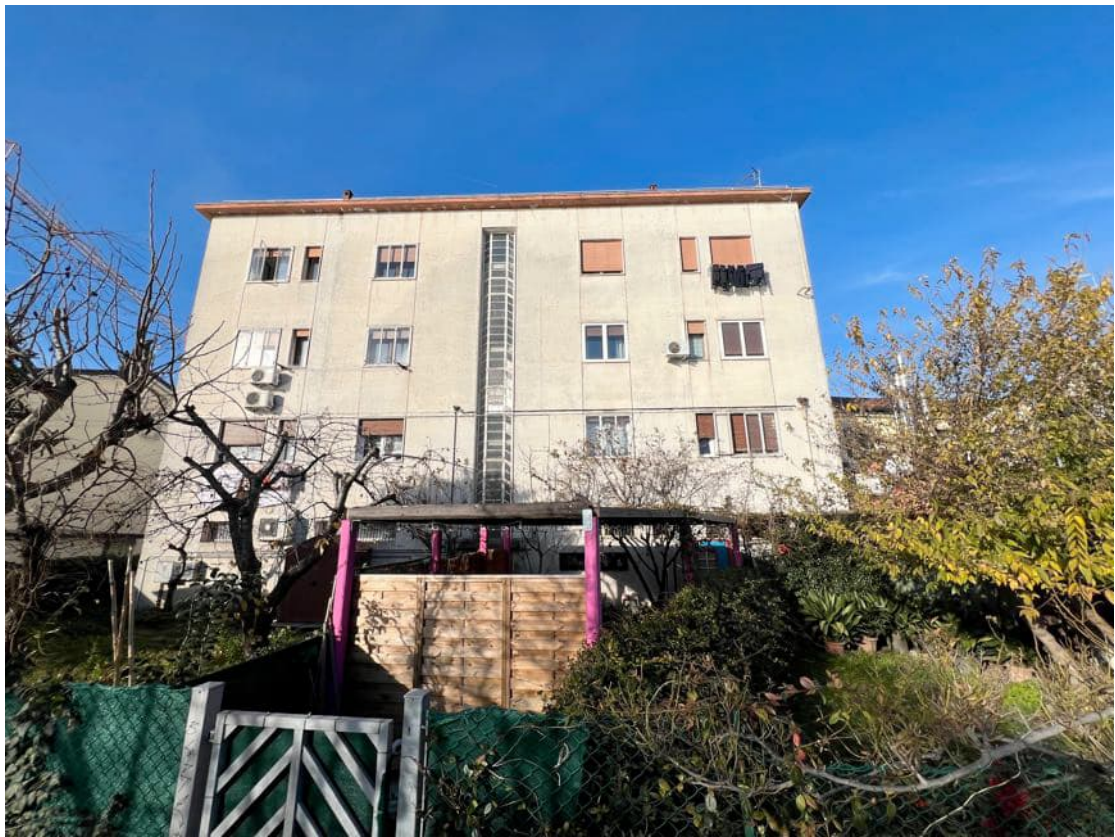
Foto n. 4 Prospetto est del fabbricato
