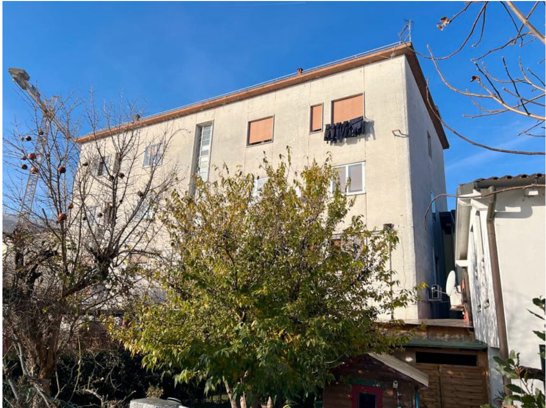
Foto n. 3 Prospetti nord ed est del fabbricato
