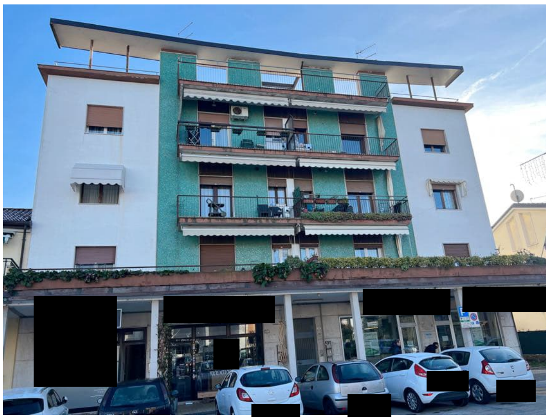
Foto n. 1 Vista del prospetto ovest del fabbricato su Piazza della Repubblica
