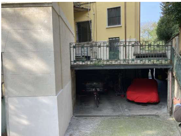
Vista altra autorimessa collegata da rampa da retro
