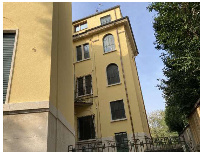
Facciata su cortile interno
