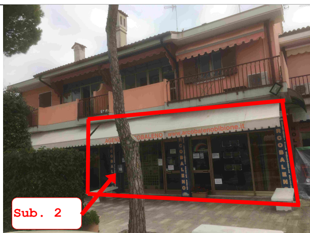
Veduta esterna fronte strada
