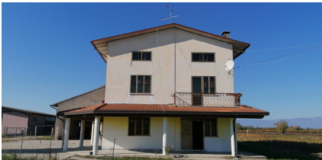
FOTO N.01 FOGLIO 4, MAPPALE 231, COMUNE DI PRAVISDOMINI (PN)
