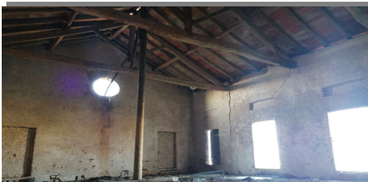
FOTO N.57 FOGLIO 4, MAPPALE 231 COMUNE DI PRAVISDOMINI (PN)
