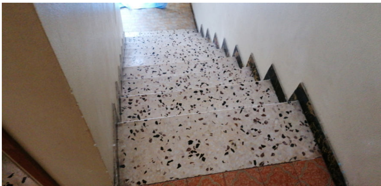
FOTO N.37 FOGLIO 4, MAPPALE 231 COMUNE DI PRAVISDOMINI (PN)
