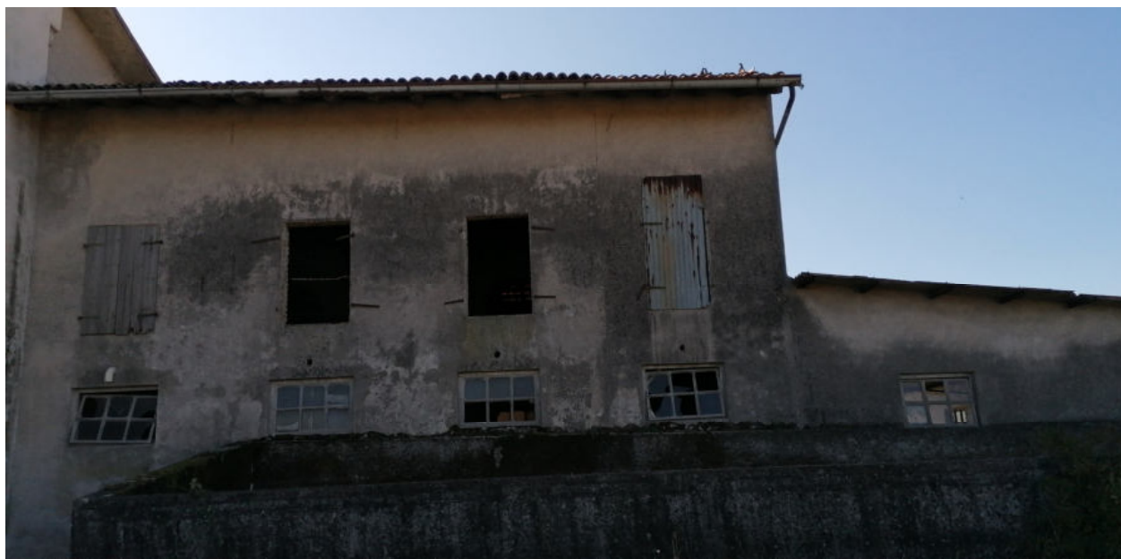
FOTO N.07 FOGLIO 4, MAPPALE 231, COMUNE DI PRAVISDOMINI (PN)
