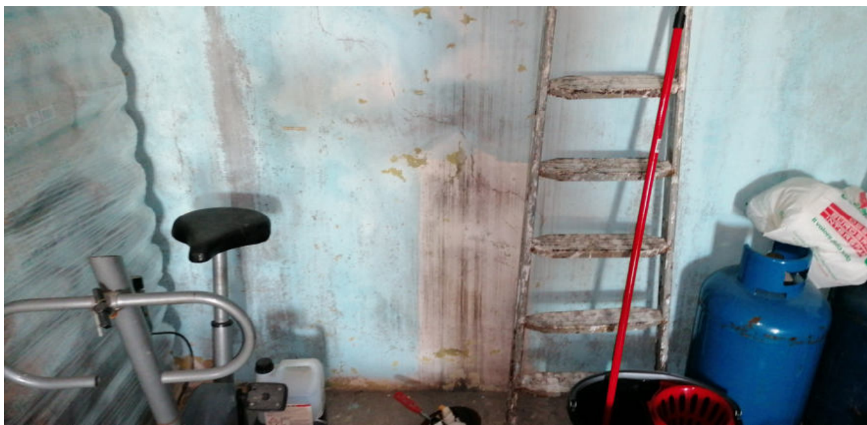
FOTO N.21 FOGLIO 4, MAPPALE 231 COMUNE DI PRAVISDOMINI (PN)
