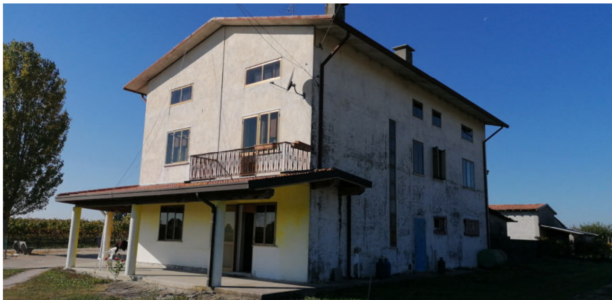
FOTO N.04 FOGLIO 4, MAPPALE 231, COMUNE DI PRAVISDOMINI (PN)
