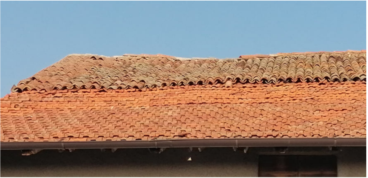
FOTO N.53 FOGLIO 4, MAPPALE 231 COMUNE DI PRAVISDOMINI (PN)
