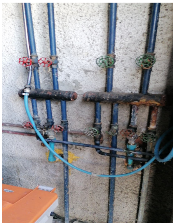
FOTO N.50 FOGLIO 4, MAPPALE 231 COMUNE DI PRAVISDOMINI (PN)
