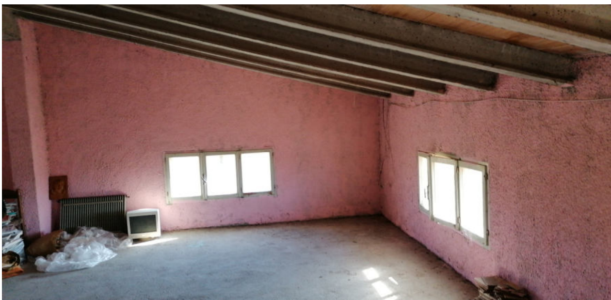
FOTO N.43 FOGLIO 4, MAPPALE 231 COMUNE DI PRAVISDOMINI (PN)
