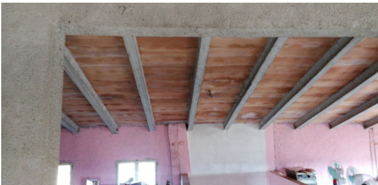
FOTO N.44 FOGLIO 4, MAPPALE 231 COMUNE DI PRAVISDOMINI (PN)
