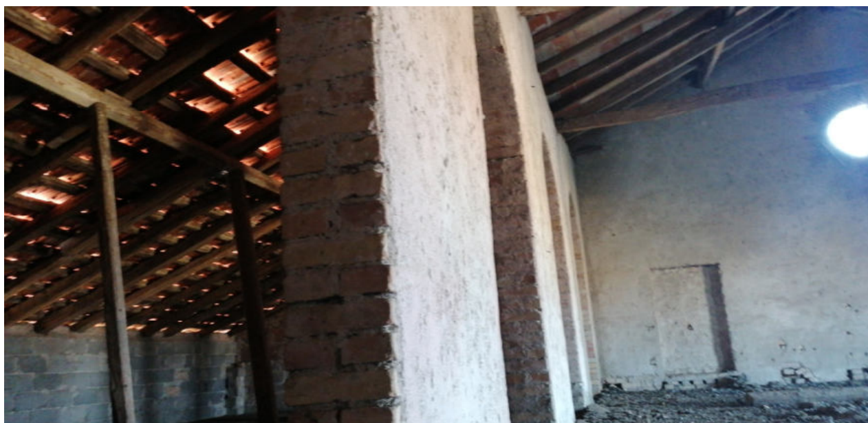
FOTO N.56 FOGLIO 4, MAPPALE 231 COMUNE DI PRAVISDOMINI (PN)
