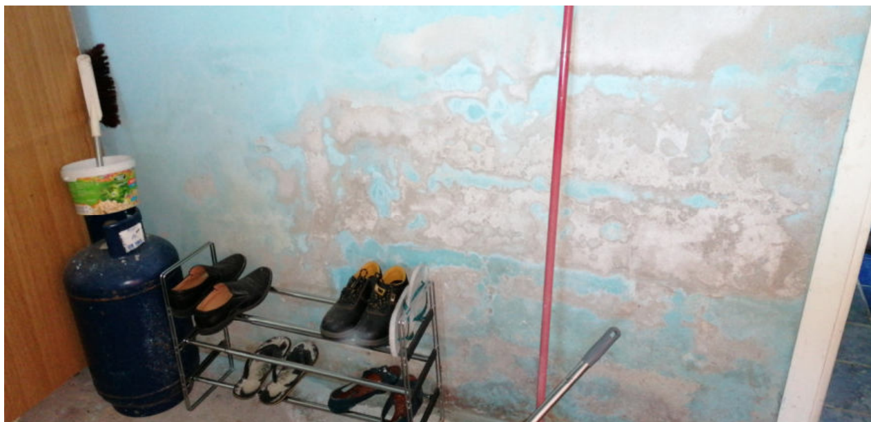
FOTO N.20 FOGLIO 4, MAPPALE 231 COMUNE DI PRAVISDOMINI (PN)
