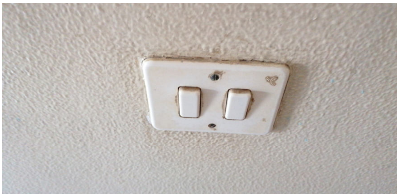
FOTO N.45 FOGLIO 4, MAPPALE 231 COMUNE DI PRAVISDOMINI (PN)
