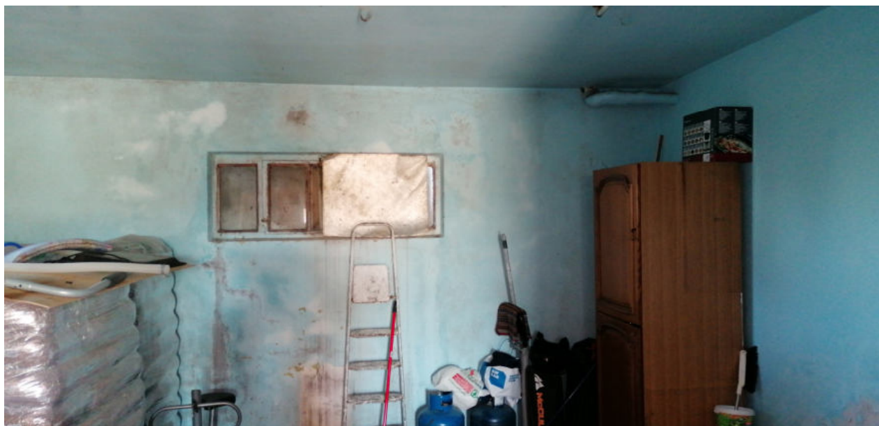
FOTO N.17 FOGLIO 4, MAPPALE 231 COMUNE DI PRAVISDOMINI (PN)
