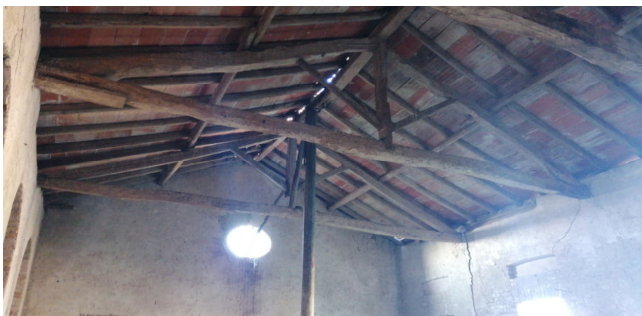
FOTO N.58 FOGLIO 4, MAPPALE 231 COMUNE DI PRAVISDOMINI (PN)
