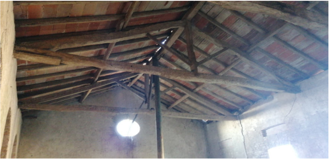
FOTO N.54 FOGLIO 4, MAPPALE 231 COMUNE DI PRAVISDOMINI (PN)
