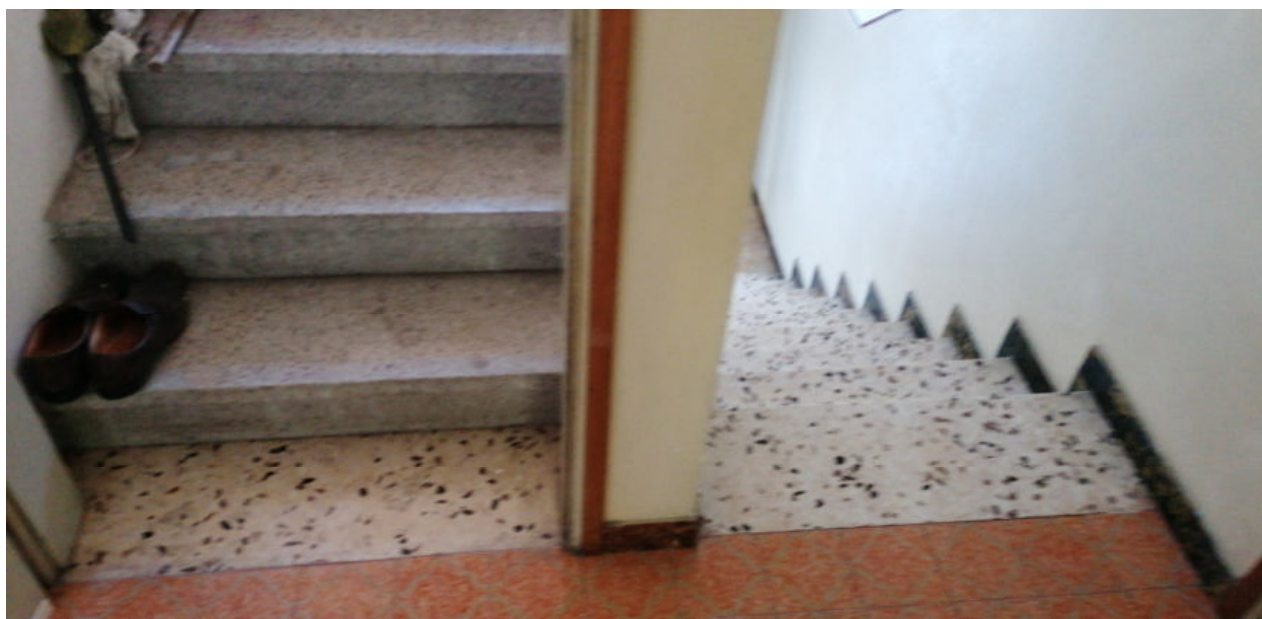
FOTO N.38 FOGLIO 4, MAPPALE 231 COMUNE DI PRAVISDOMINI (PN)
