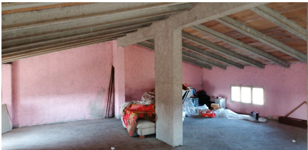
FOTO N.42 FOGLIO 4, MAPPALE 231 COMUNE DI PRAVISDOMINI (PN)
