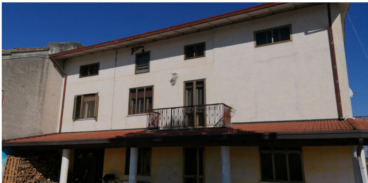
FOTO N.03 FOGLIO 4, MAPPALE 231, COMUNE DI PRAVISDOMINI (PN)
