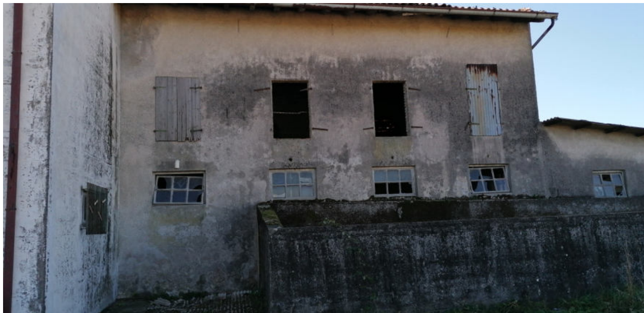
FOTO N.09 FOGLIO 4, MAPPALE 231, COMUNE DI PRAVISDOMINI (PN)
