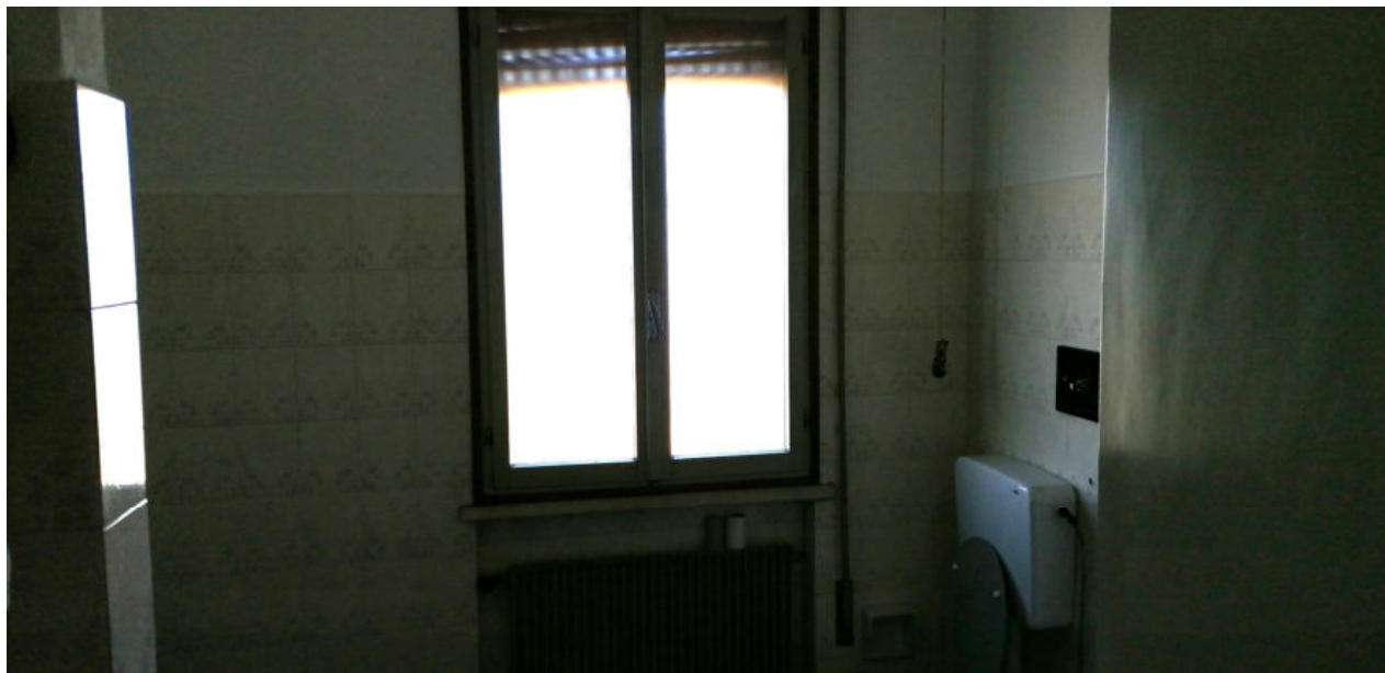
FOTO N.25 FOGLIO 4, MAPPALE 231 COMUNE DI PRAVISDOMINI (PN)
