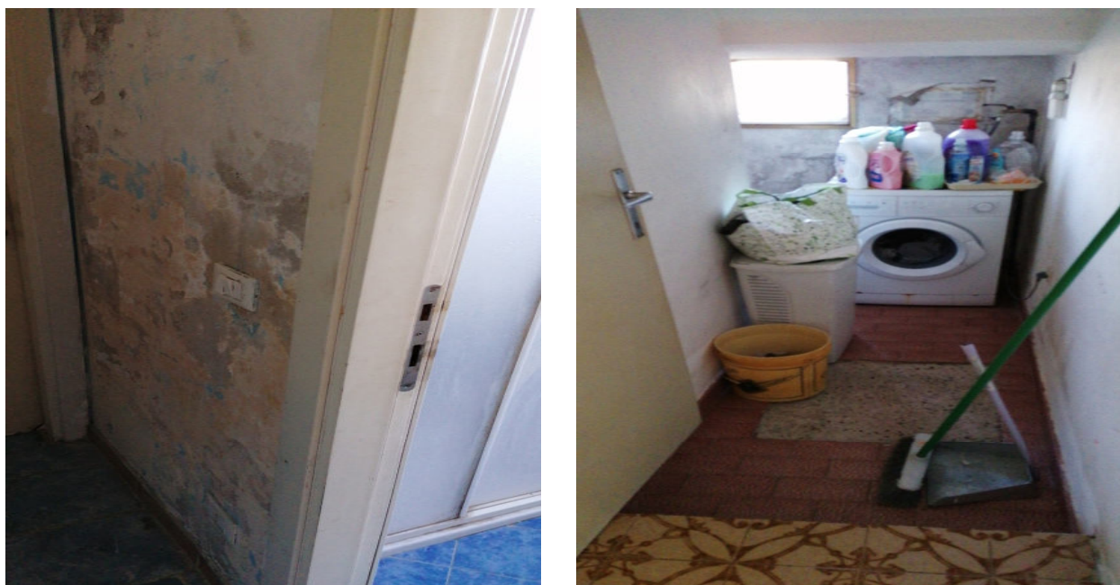
FOTO N.47 FOGLIO 4, MAPPALE 231 COMUNE DI PRAVISDOMINI (PN)
