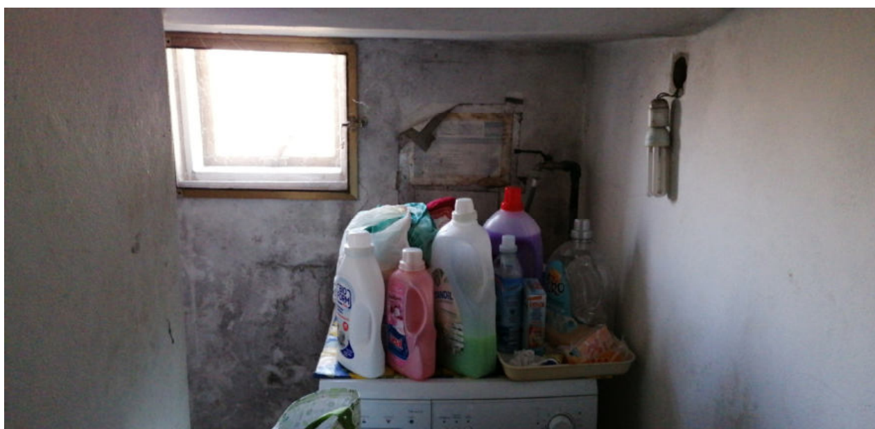
FOTO N.48 FOGLIO 4, MAPPALE 231 COMUNE DI PRAVISDOMINI (PN)
