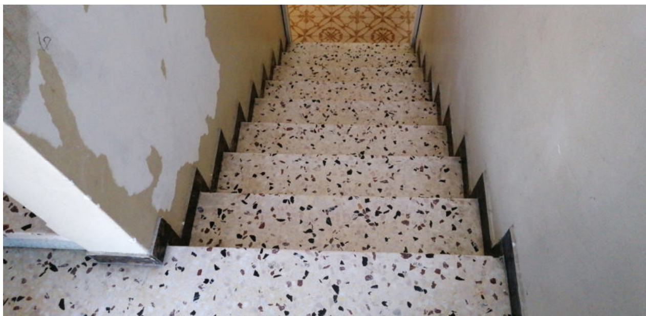
FOTO N.46 FOGLIO 4, MAPPALE 231 COMUNE DI PRAVISDOMINI (PN)
