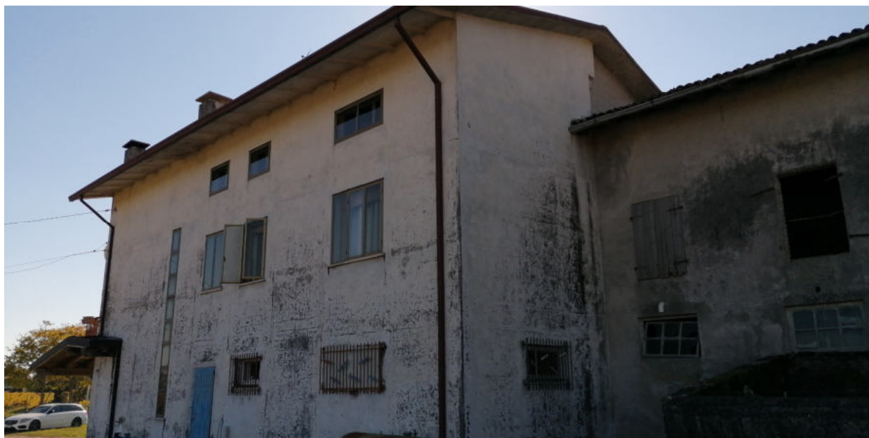
FOTO N.05 FOGLIO 4, MAPPALE 231, COMUNE DI PRAVISDOMINI (PN)
