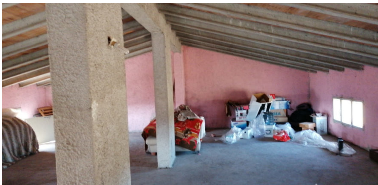
FOTO N.41 FOGLIO 4, MAPPALE 231 COMUNE DI PRAVISDOMINI (PN)
