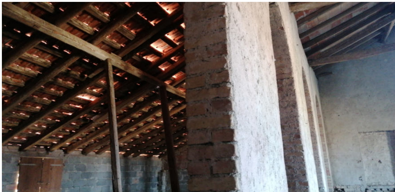
FOTO N.55 FOGLIO 4, MAPPALE 231 COMUNE DI PRAVISDOMINI (PN)
