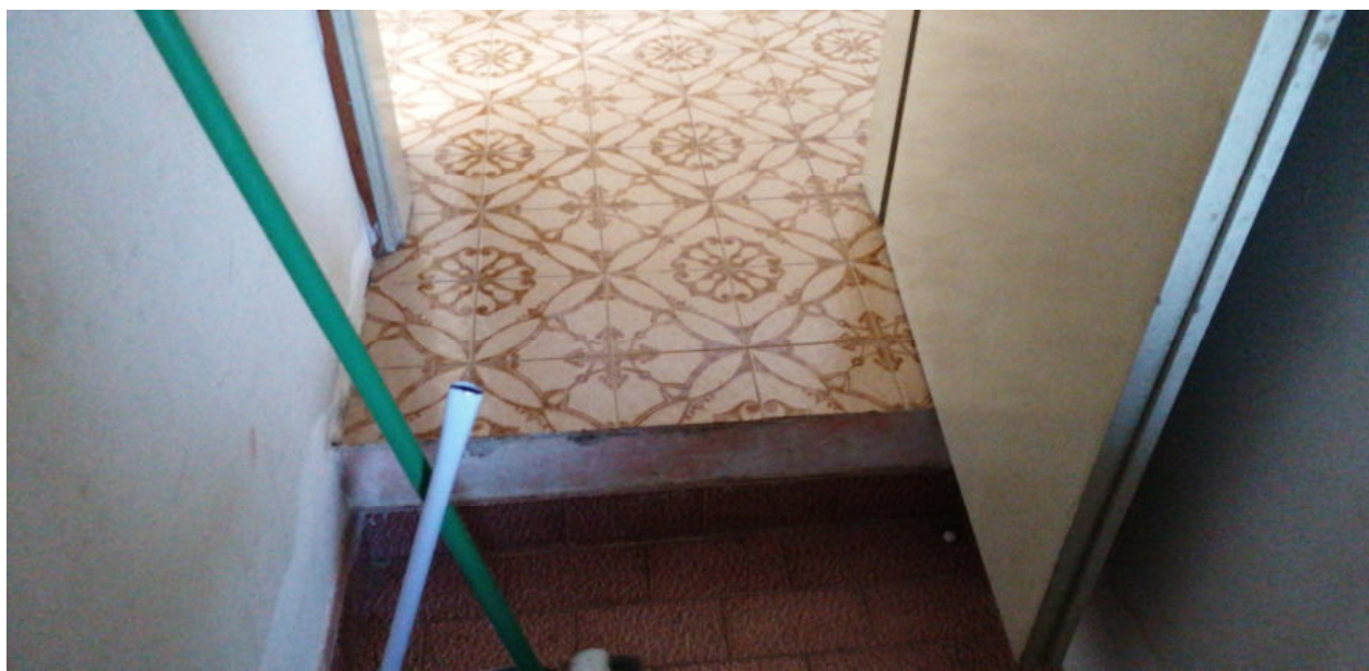
FOTO N.49 FOGLIO 4, MAPPALE 231 COMUNE DI PRAVISDOMINI (PN)
