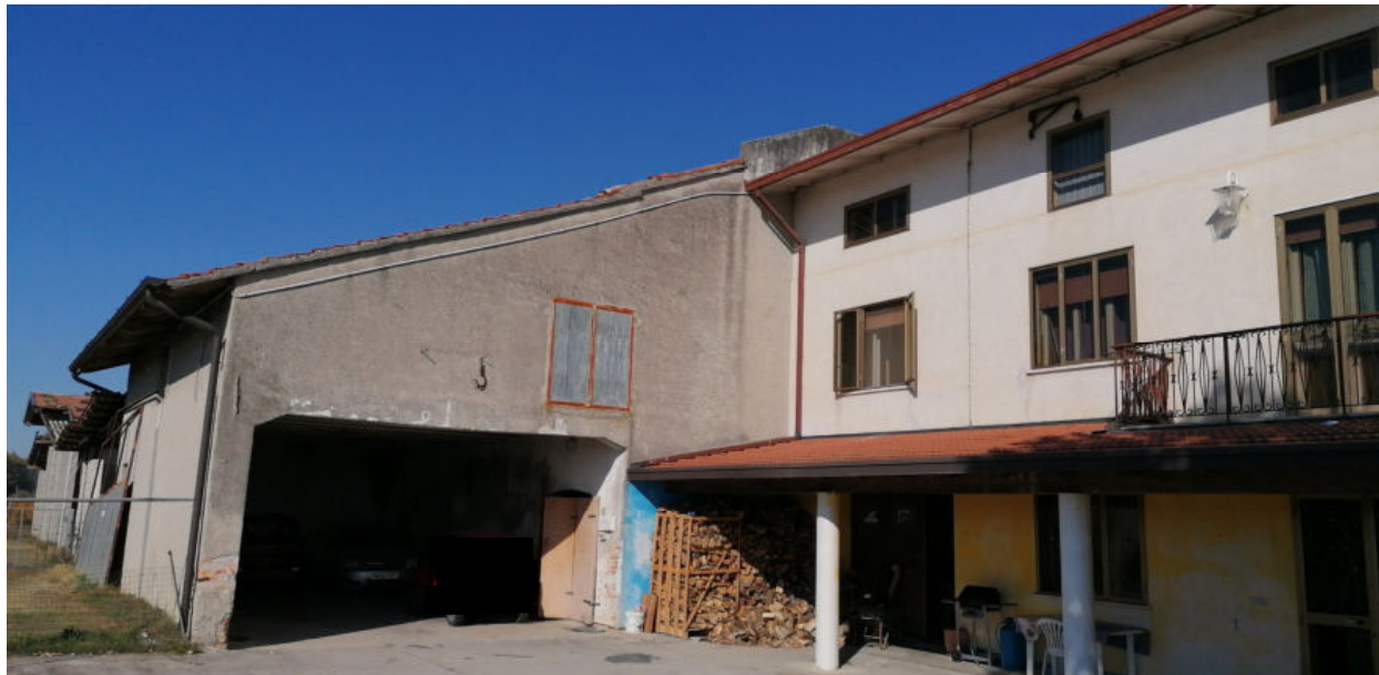
FOTO N.02 FOGLIO 4, MAPPALE 231, COMUNE DI PRAVISDOMINI (PN)
