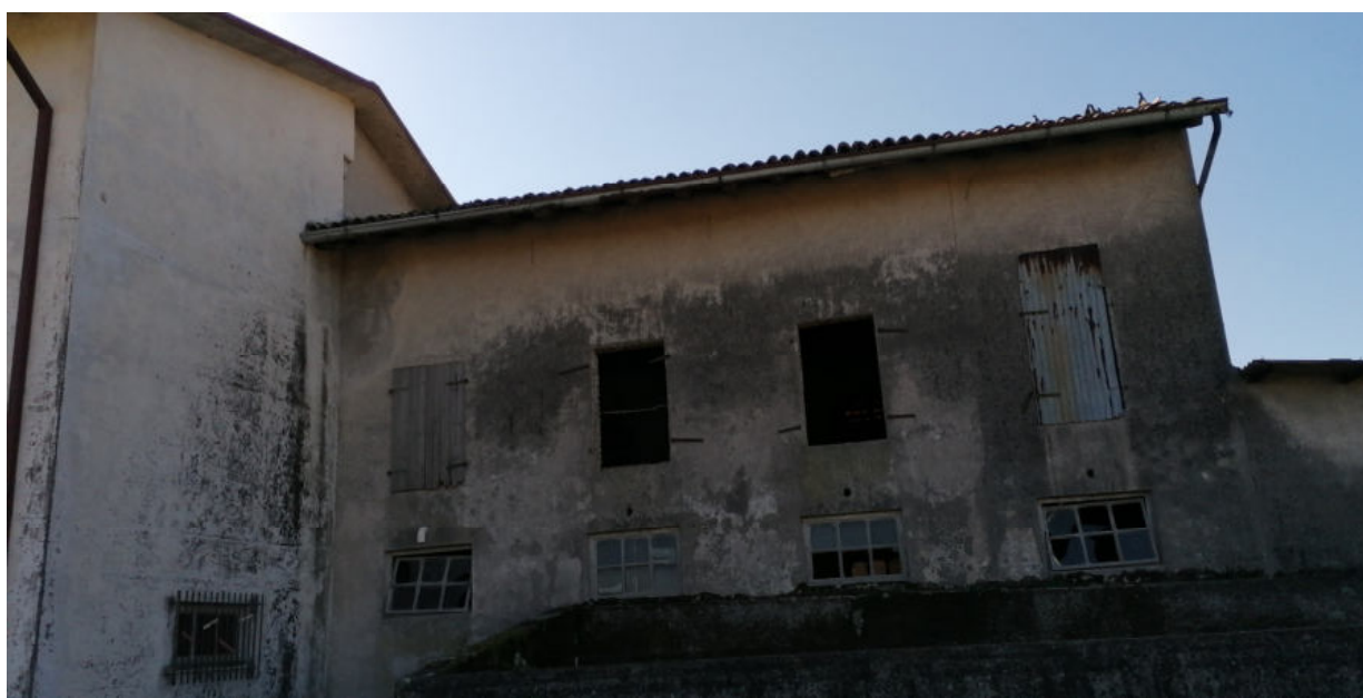
FOTO N.06 FOGLIO 4, MAPPALE 231, COMUNE DI PRAVISDOMINI (PN)
