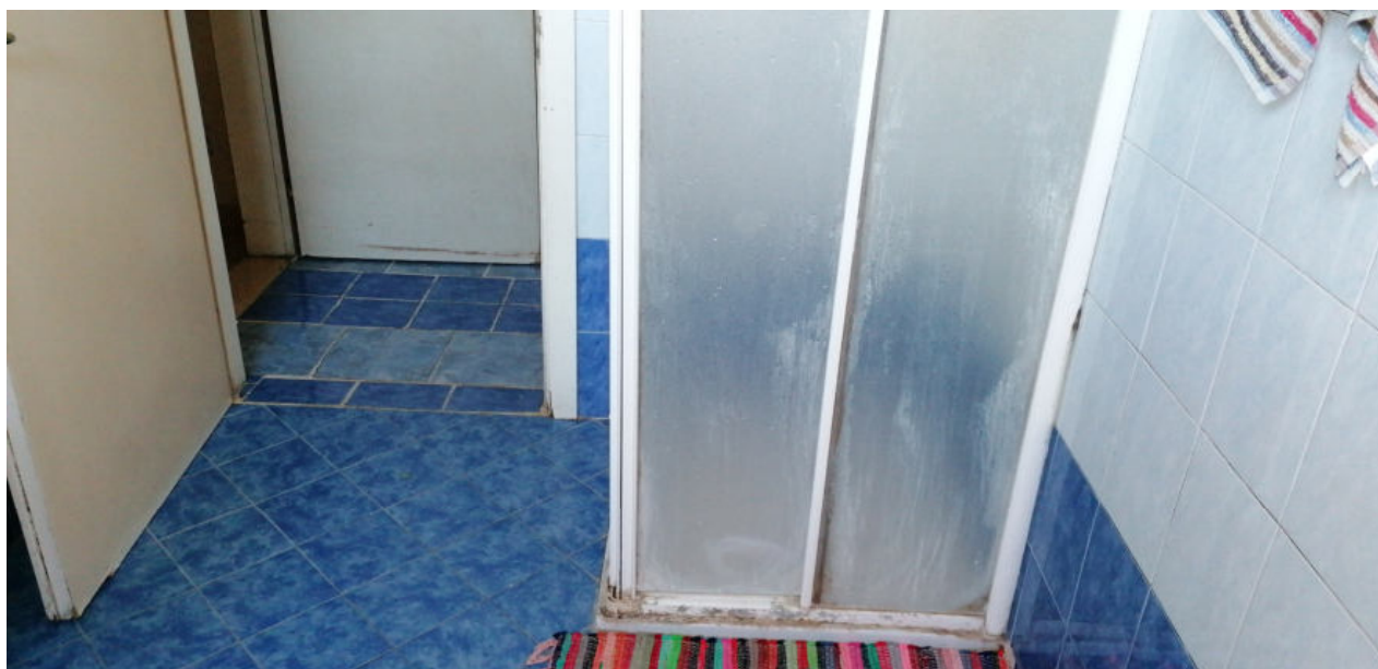
FOTO N.16 FOGLIO 4, MAPPALE 231 COMUNE DI PRAVISDOMINI (PN)
