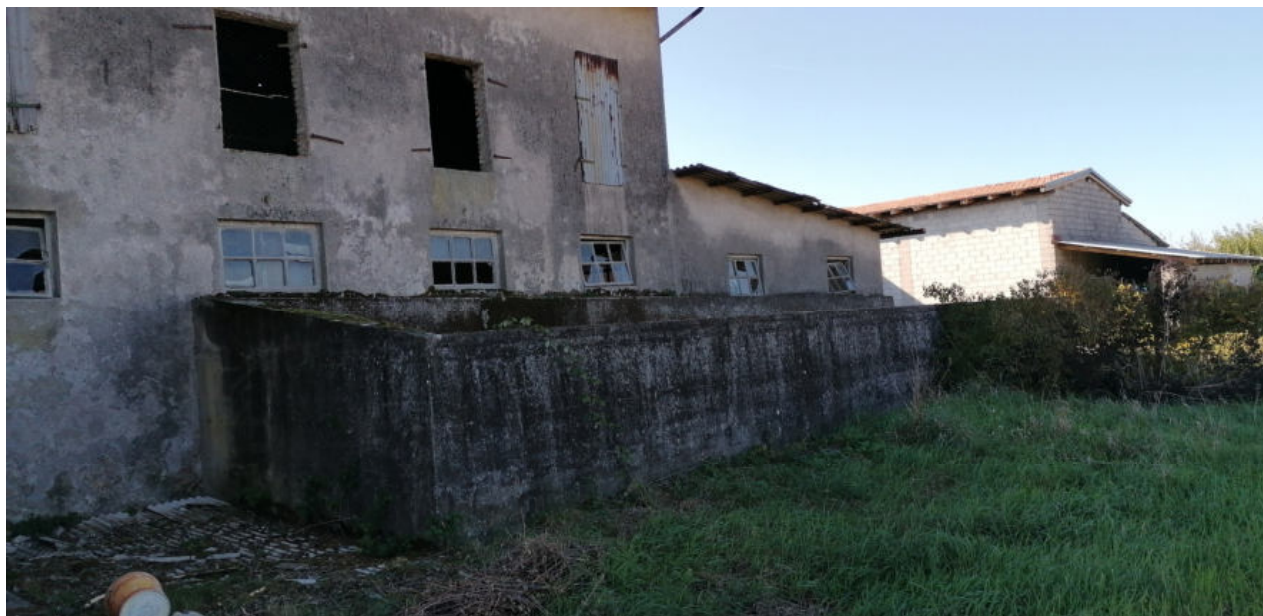
FOTO N.08 FOGLIO 4, MAPPALE 231, COMUNE DI PRAVISDOMINI (PN)
