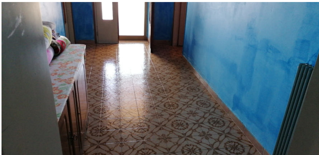
FOTO N.12 FOGLIO 4, MAPPALE 231, COMUNE DI PRAVISDOMINI (PN)
