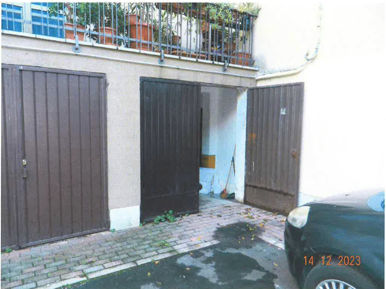
Vista esterna del garage ubicato al piano terra (sub. 5)
