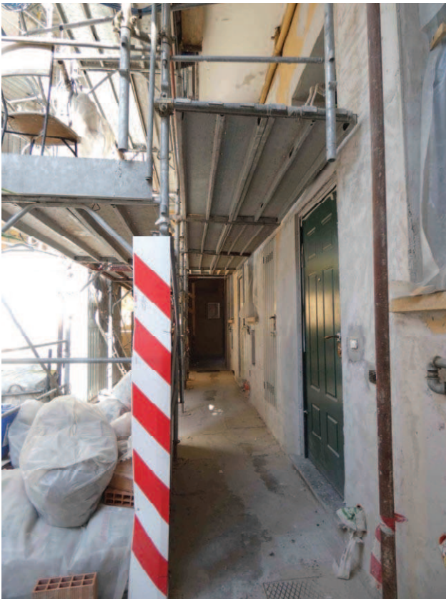
Foto 3. Accesso al vano scale dal cortile comune
