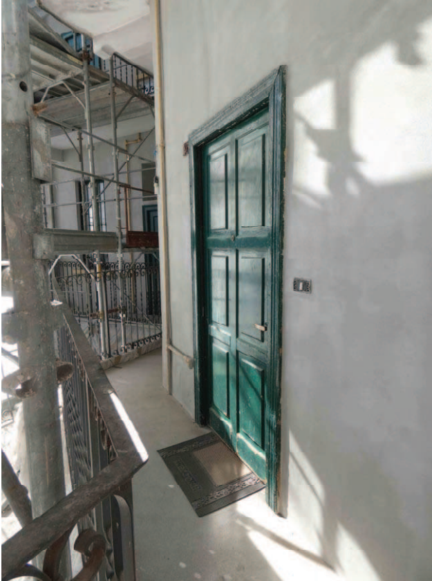
Foto 5. Porta d'accesso all'appartamento
