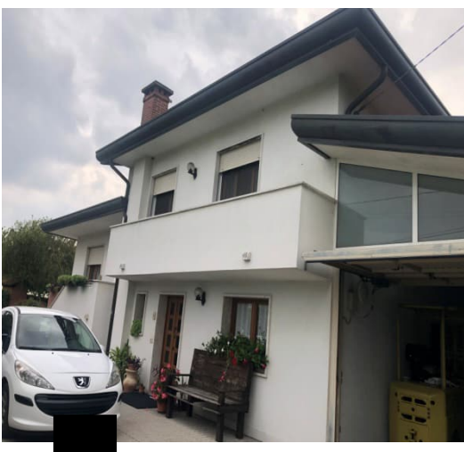
Prospetto EST con vista sul garage
