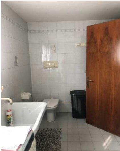
Vista lavanderia P.T.
