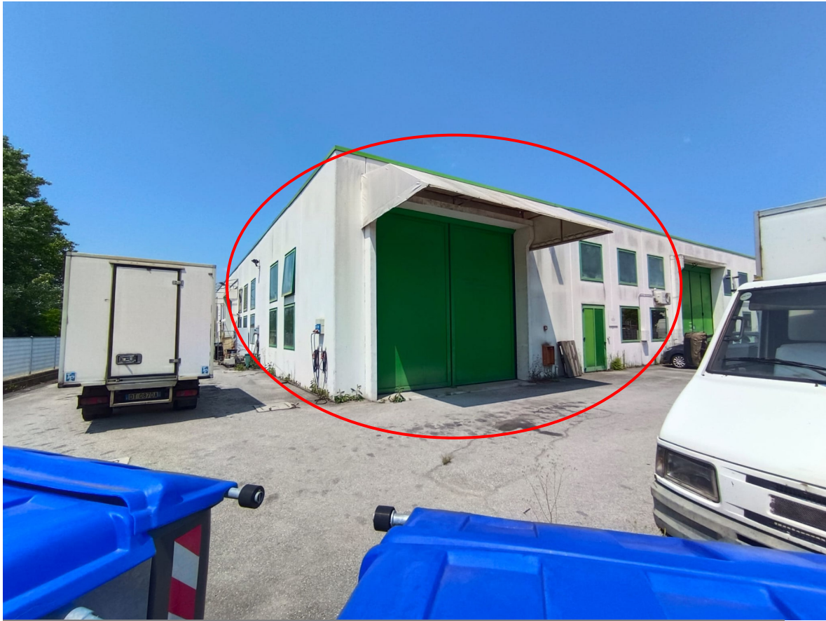
Porzione capannone uso artigianale/magazzino Martellago Via Sandro Pertini 24/B
