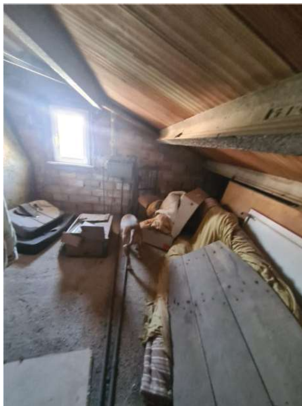
Foto 12: Interno piano secondo: soffitta
