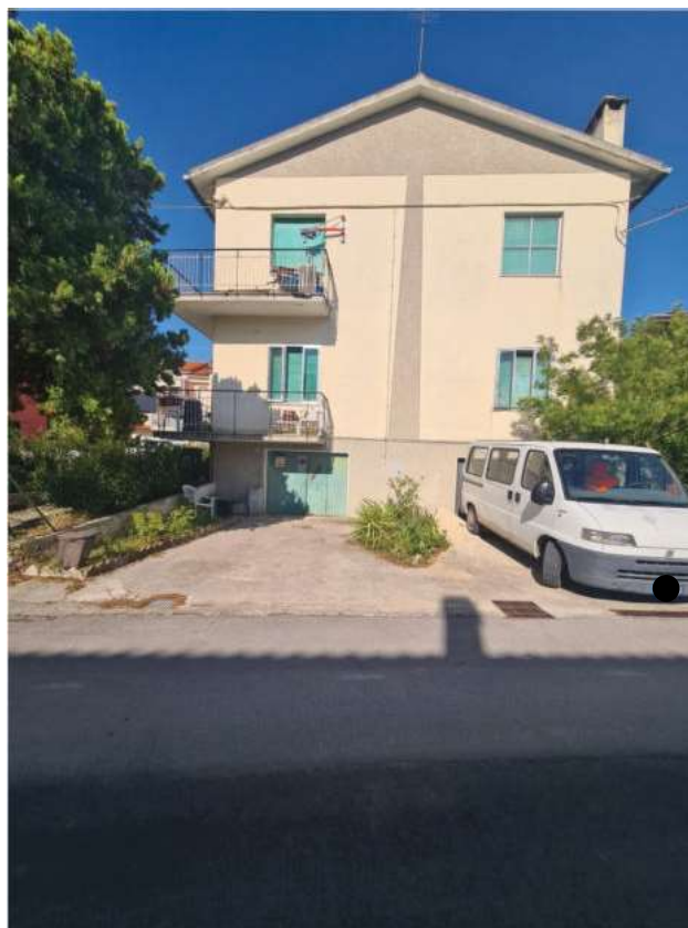
Foto 2: Vista prospetto Est
