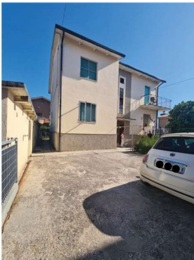
Foto 1: Vista prospetto Sud
