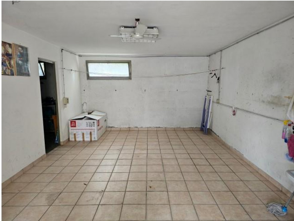
FOTO 25: INTERNO GARAGE (SUB. 20 – P.Int.)
