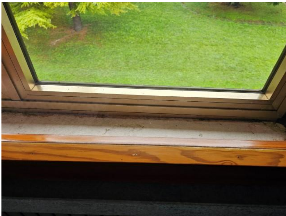
FOTO 18: PARTICOLARE SERRAMENTO (SUB. 10 – 1°P.)
