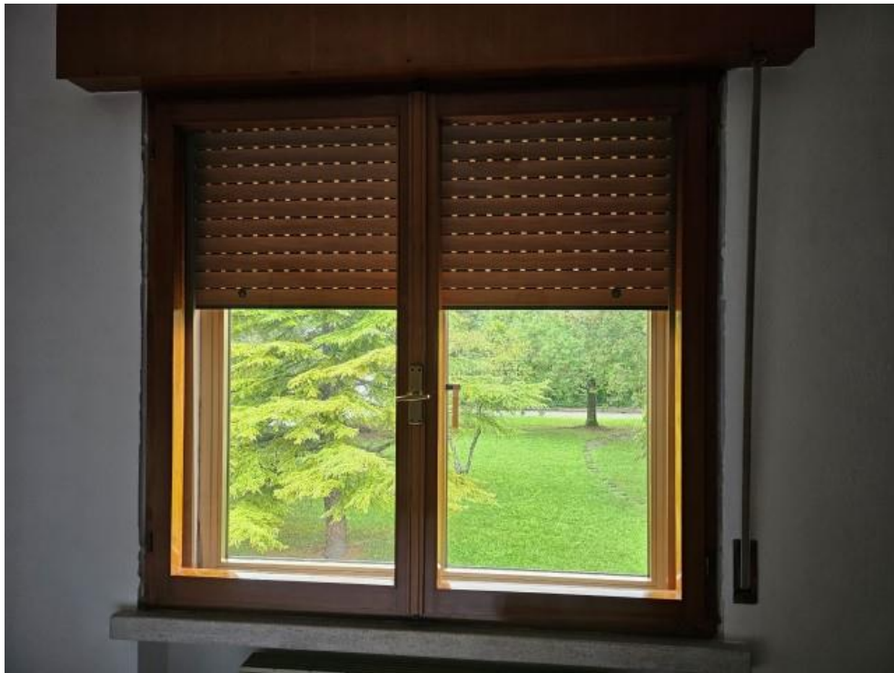
FOTO 17: SERRAMENTO (SUB. 10 – 1°P.)
