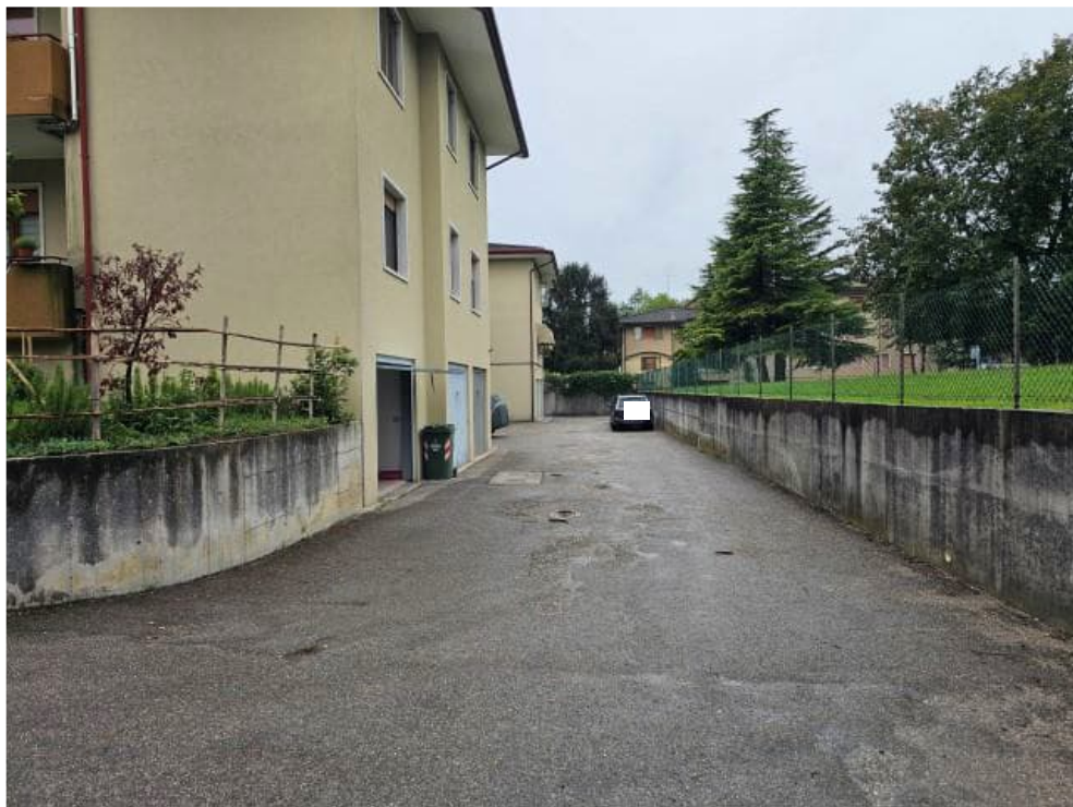
FOTO 6: AREA MANOVRA CONDOMINIALE PIANO SEMINTERRATO
