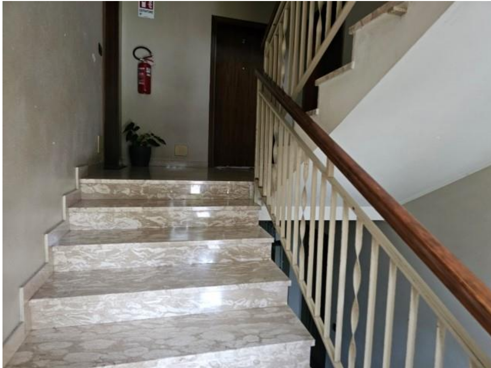
FOTO 7: VANO SCALE CONDOMINIALE
