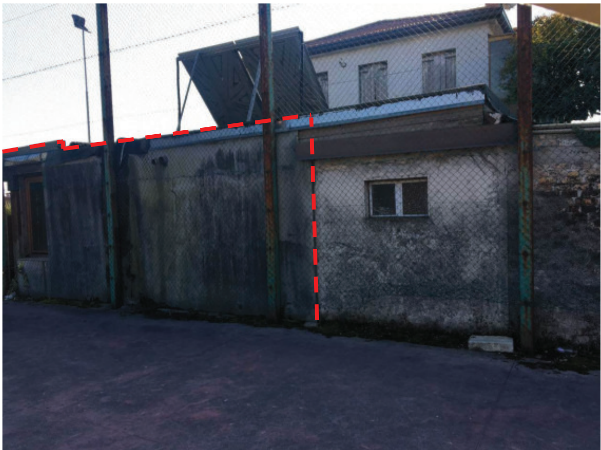
Foto n.4: Facciata Nord del Condominio con evidenziata la porzione accessoria dell'Appartamento oggetto di E.I. ( Sub.5-7/porz ).
