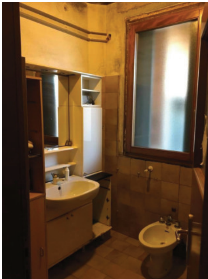
Foto n.21: Bagno principale (Sub.1).
