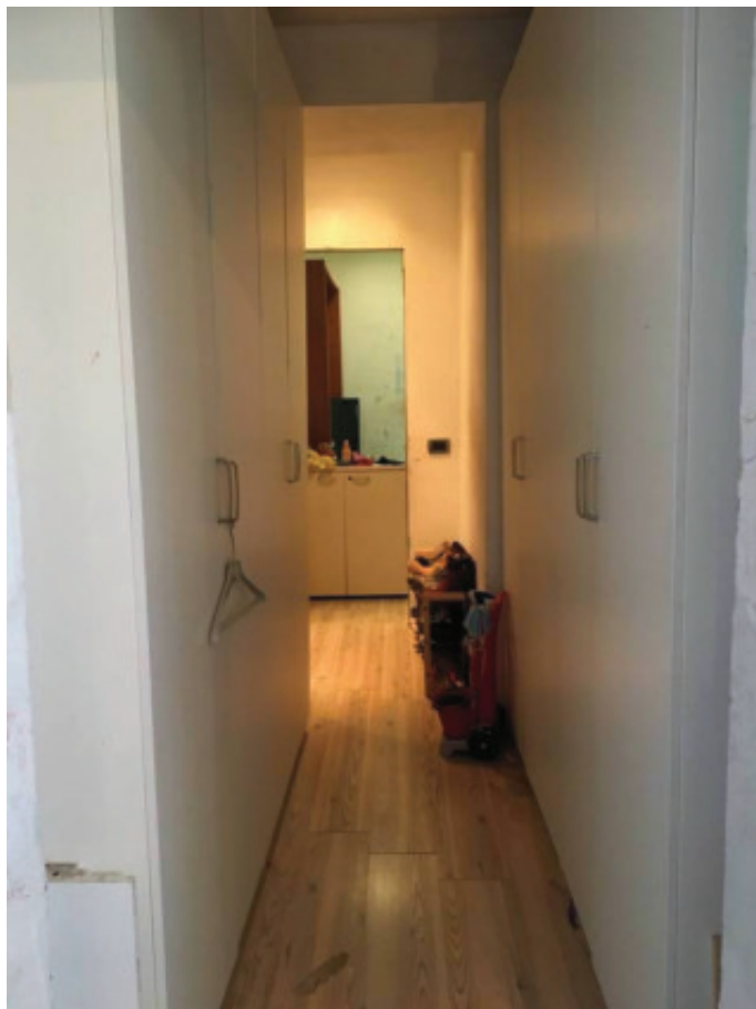
Foto n.16: Disimpegno tra zona giorno e zona notte, difforme da quanto assentito dal Comune ( Sub.1 ).
