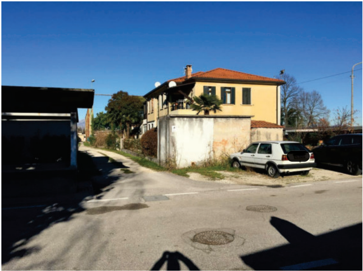
Foto n.1: Prospetti Sud ed Ovest del Fabbricato Condominiale dov'è ubicato l'Appartamento oggetto di E.I., visto dalla via pubblica Eritrea.
