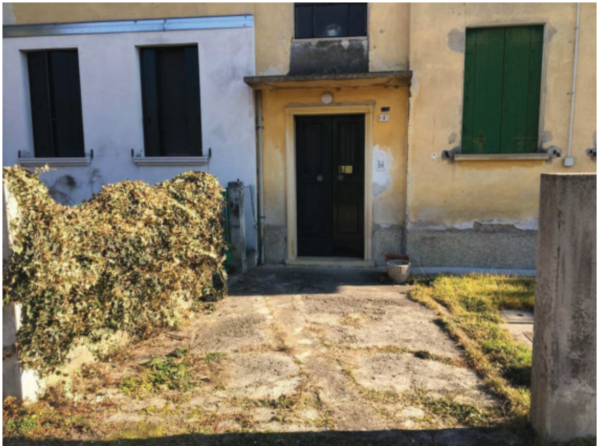
Foto n.8: Area d'accesso comune ( Sub.11 ) antistante al portoncino d'ingresso alla palazzina condominiale che, posto ad ovest, è accessibile dalla stradina sterrata di lottizzazione, laterale di via Eritrea.
