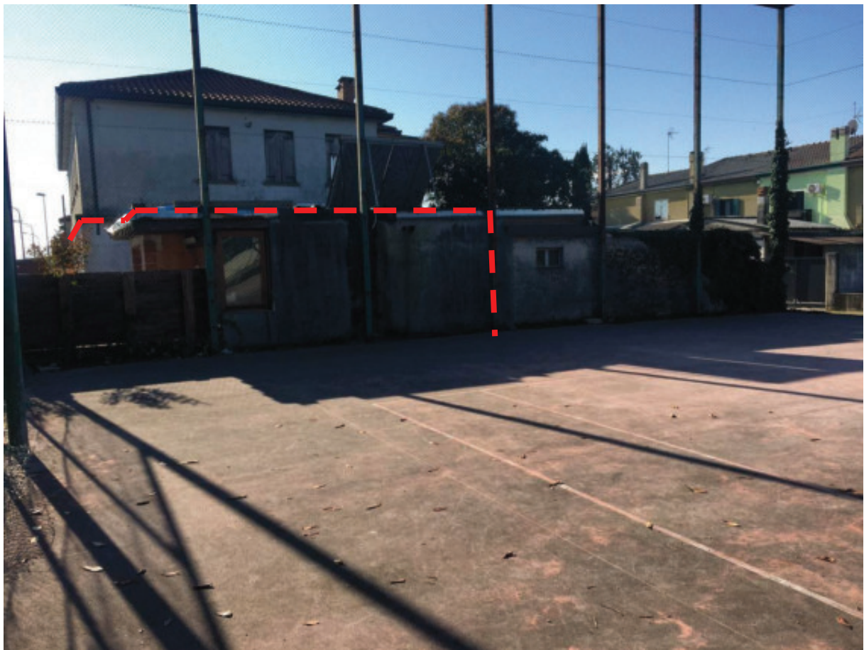
Foto n.3: Prospetto Nord del Fabbricato Condominiale, visto dal campo da tennis ( Mapp.28 ), con indicata la parte accessoria dell'Appartamento oggetto di E.I.
