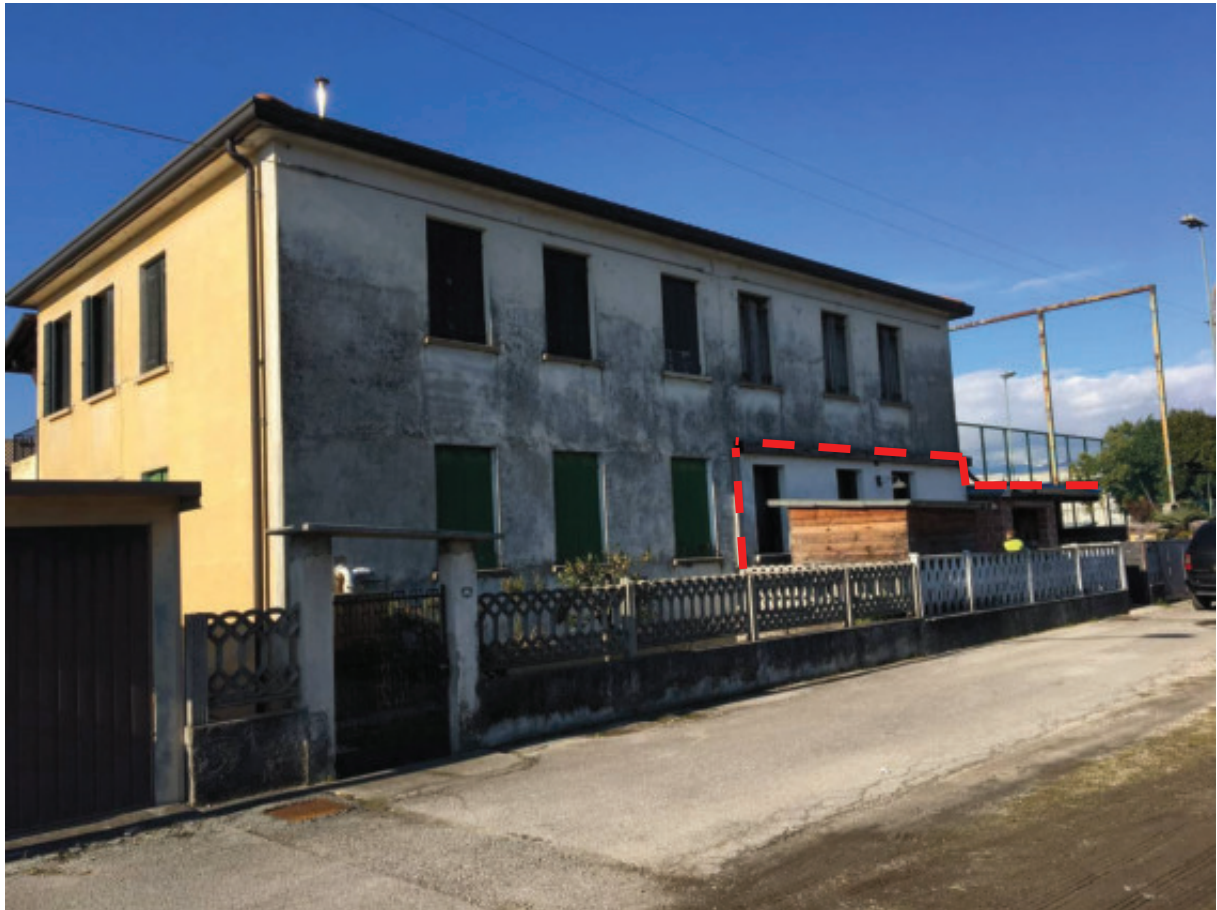
Foto n.5: Facciate Sud ed Est della palazzina condominiale, viste dalla strada ad uso pubblico quale laterale di via Eritrea, con evidenziato l'Appartamento oggetto di E.I. (Sub.1).
