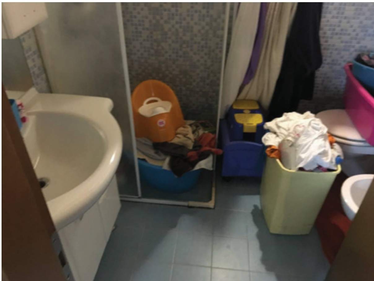
Foto n.14: Bagno abusivo realizzato in luogo dell'originario Ripostiglio isolato ( Sub.1 ), privo di antibagno verso la zona giorno cucina/pranzo.
