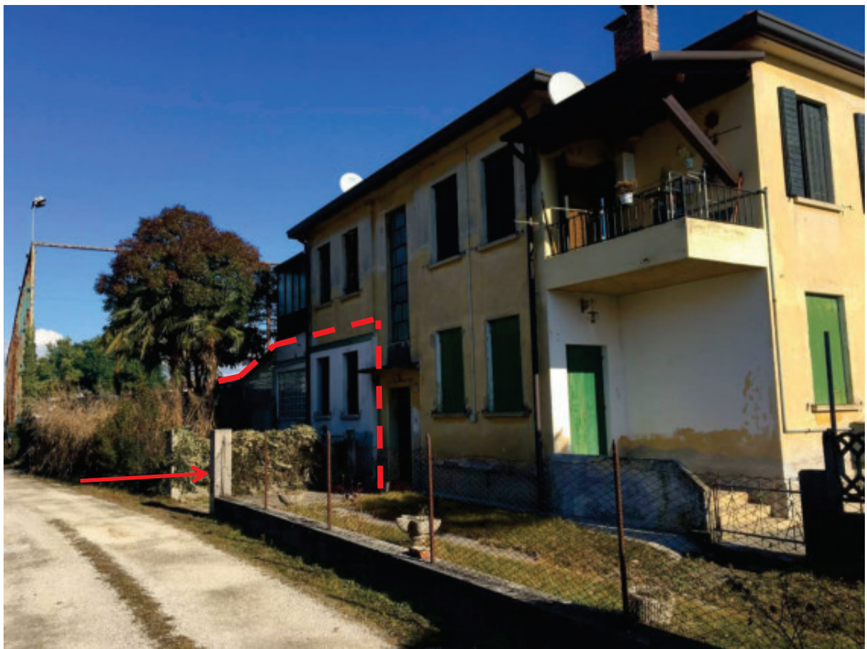
Foto n.2: Prospetto Ovest del Fabbricato Condominiale, visto dalla strada privata di lottizzazione ( Mapp.405-426-428-429-309 ), quale laterale di Via Eritrea, con evidenziato l'Appartamento oggetto di E.I. e dell'accesso comune al vano scala condominiale ( Sub.11 ).
