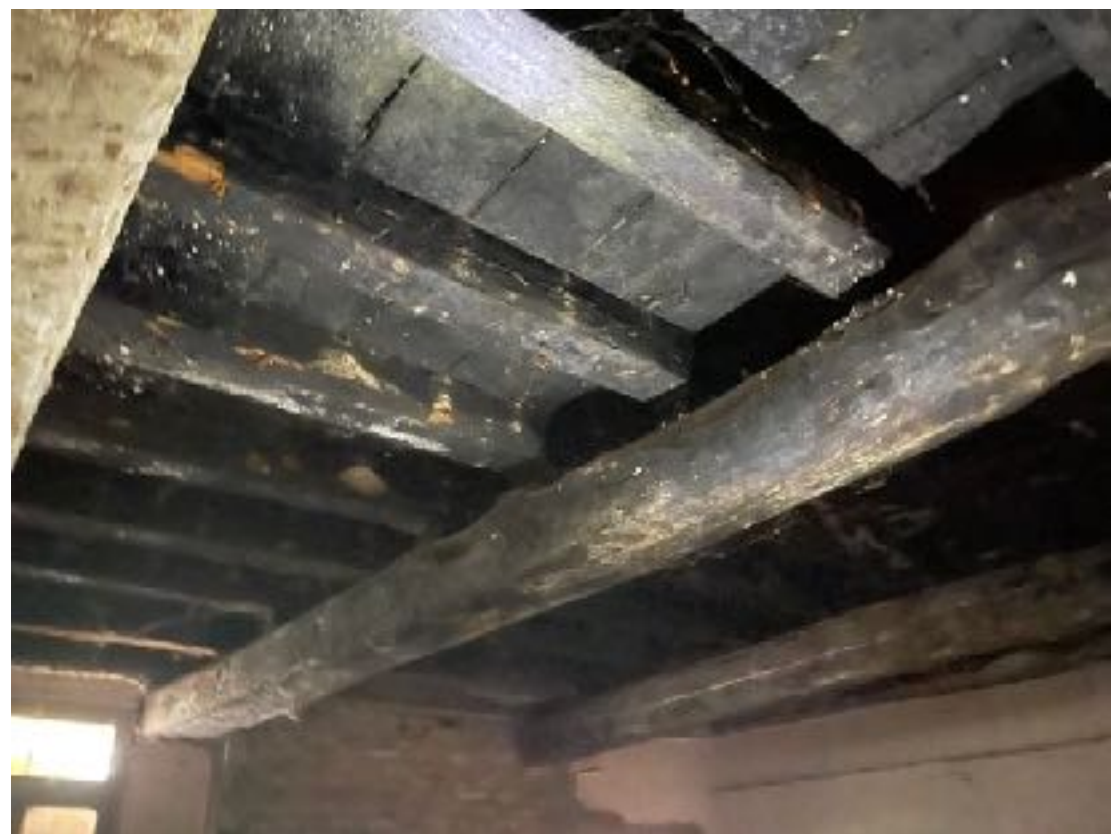
Particolare orditura solai piano terra
