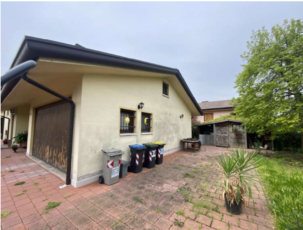
FOTO 2: Vista fabbricato lato nord e casetta in legno da rimuovere
