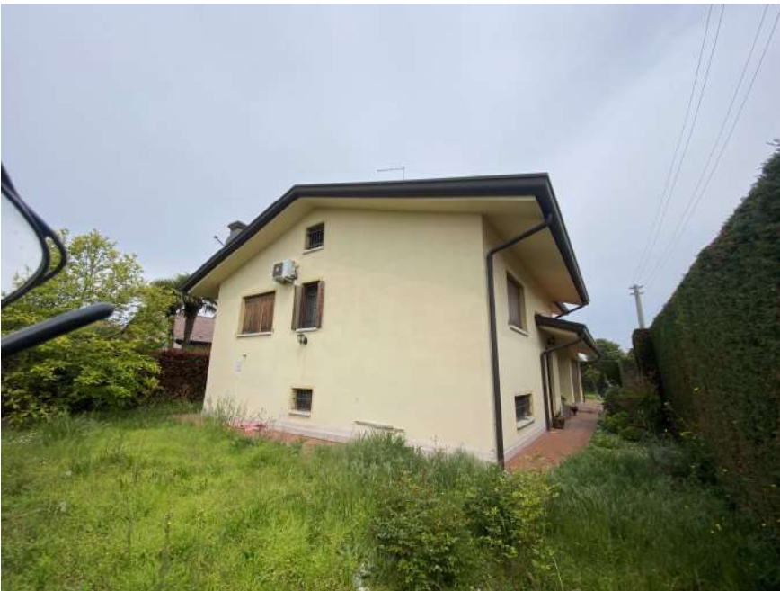
FOTO 4: Vista fabbricato lato sud
