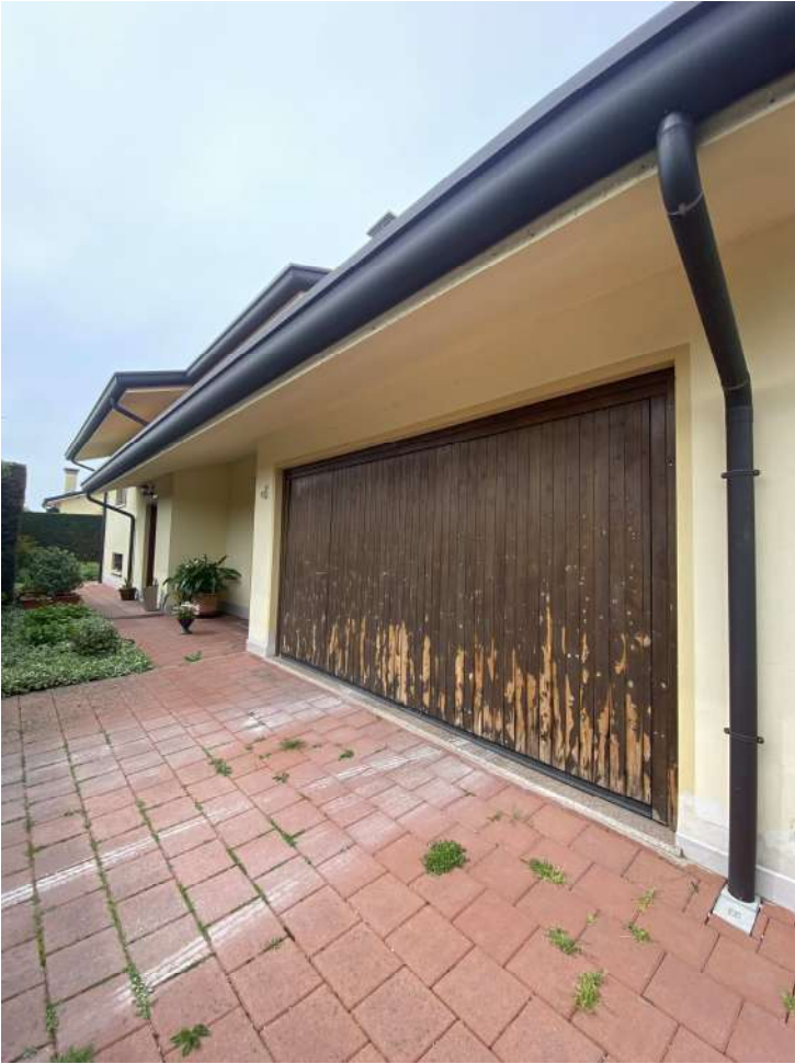
FOTO 3: Vista fabbricato lato est
