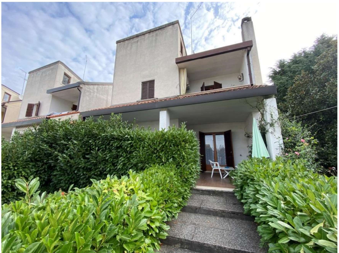
FOTO 2 ESTERNO ACCESSO ABITAZIONE
