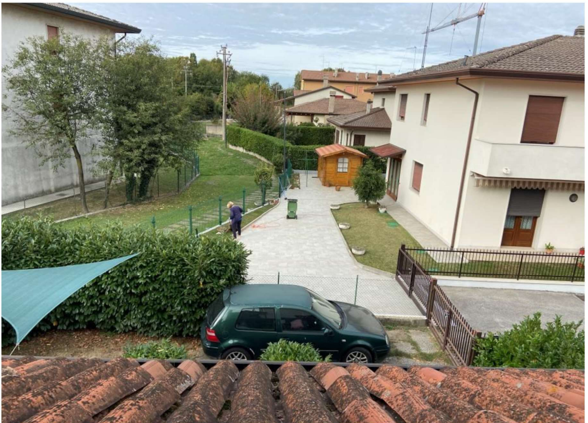
FOTO 11 ESTRENO DAL PRIMO PIANO VERSO L'ACCESSO
