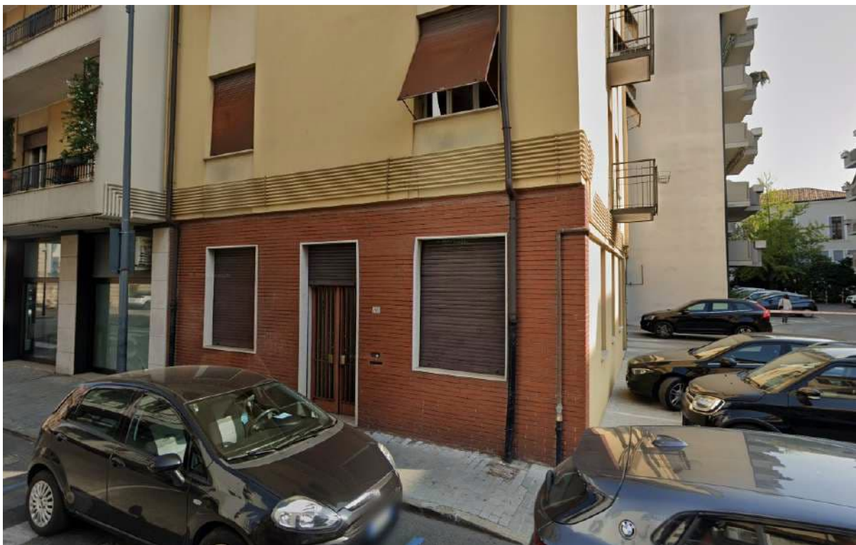
Vista dell'ufficio da Via Jesolo
