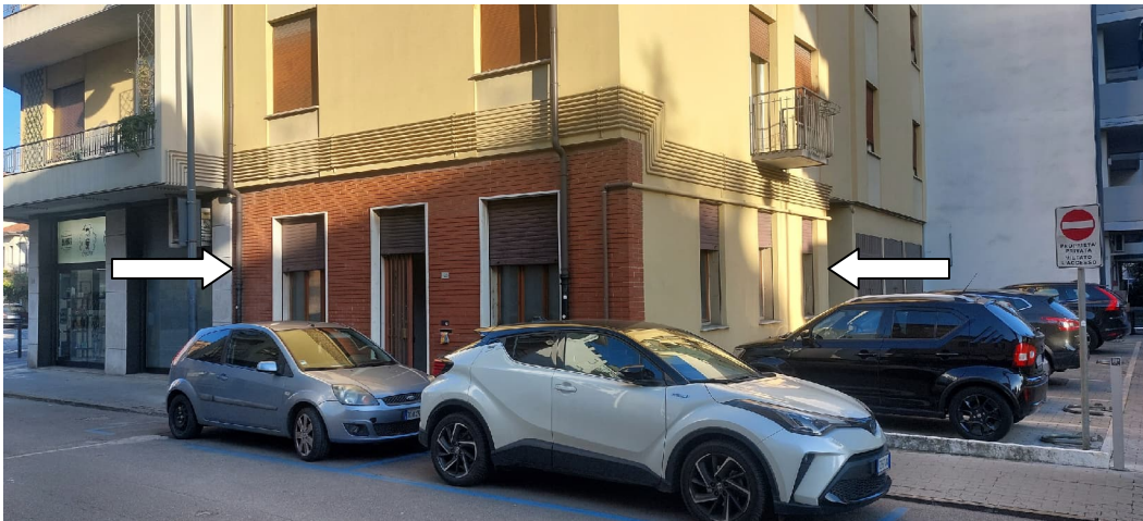
Vista dell'immobile da Via Jesolo (VE)
