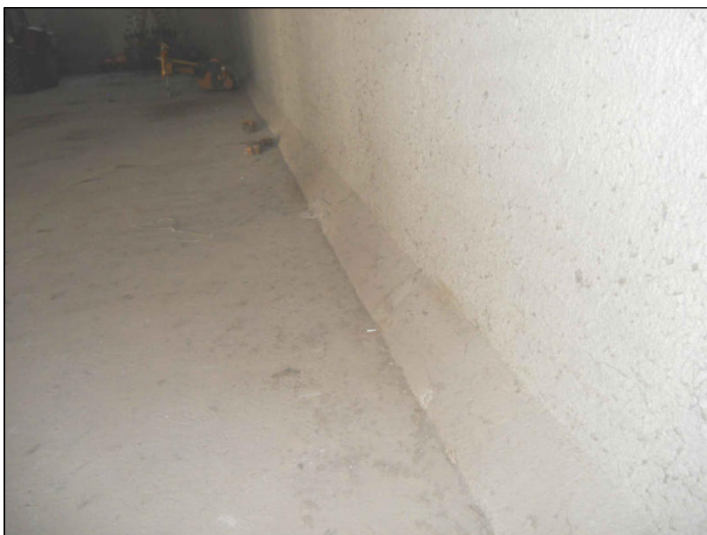
FOTO N°2 - VISTA DEL PAVIMENTO E DELLE PARETI
