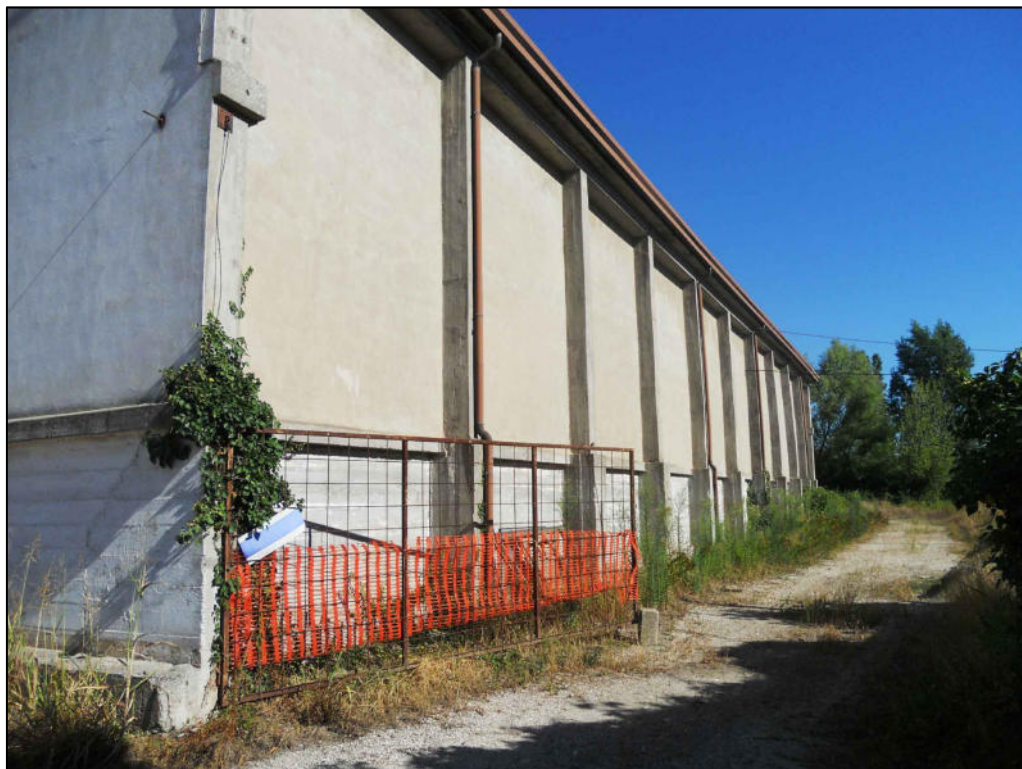
FOTO N°3 - VISTA DA SUD - EST
