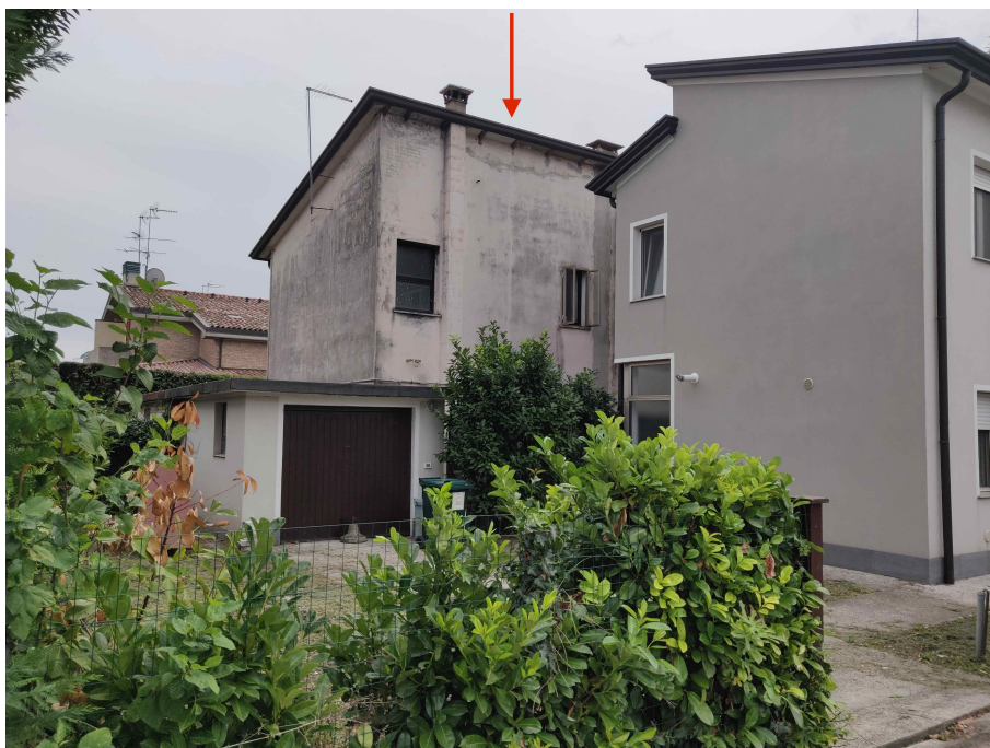
foto 2: veduta dell'u.i. corpo A – abitazione da via Vittorio Veneto
