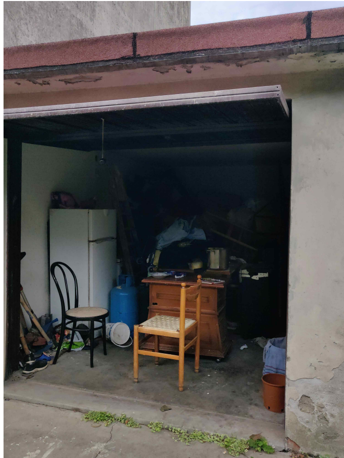
foto 17: veduta interna del corpo B - garage
