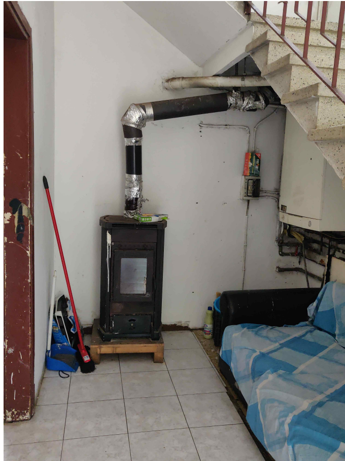
foto 6: ingresso p.t. corpo A - abitazione
