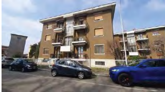
VIA A. DE GASPERI, 7 - FRONTE
