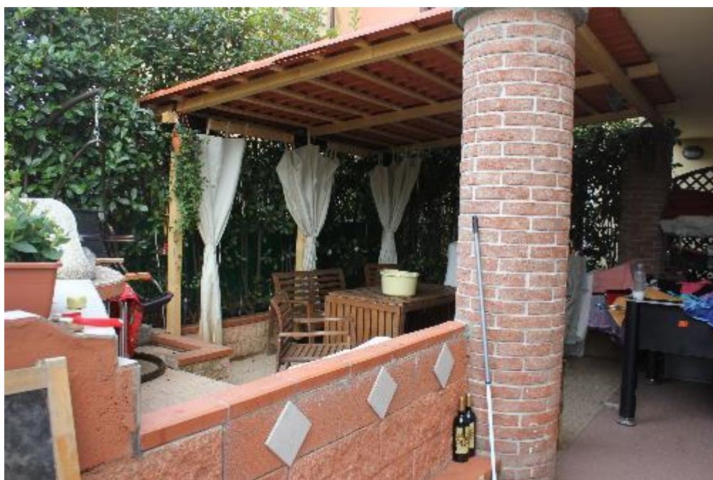
FOTO 20: TREZZANO S/N (MI), VIA MORONA 10, portico
