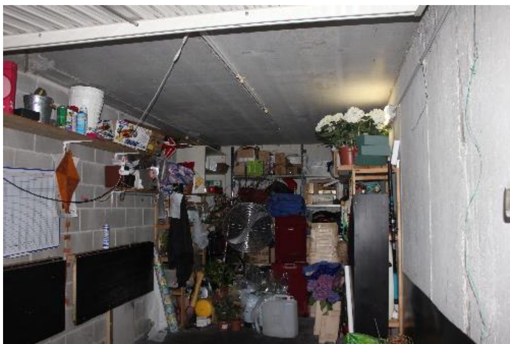
FOTO 28: TREZZANO S/N (MI), VIA MORONA 10, box sub. 132
