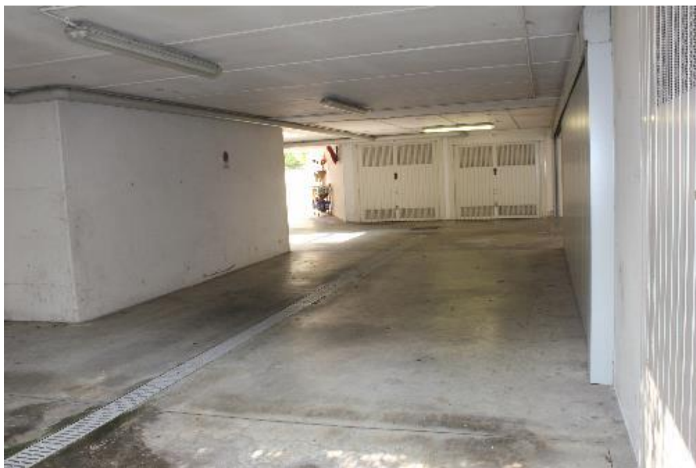
FOTO 29: TREZZANO S/N (MI), VIA MORONA 10, corsello box
