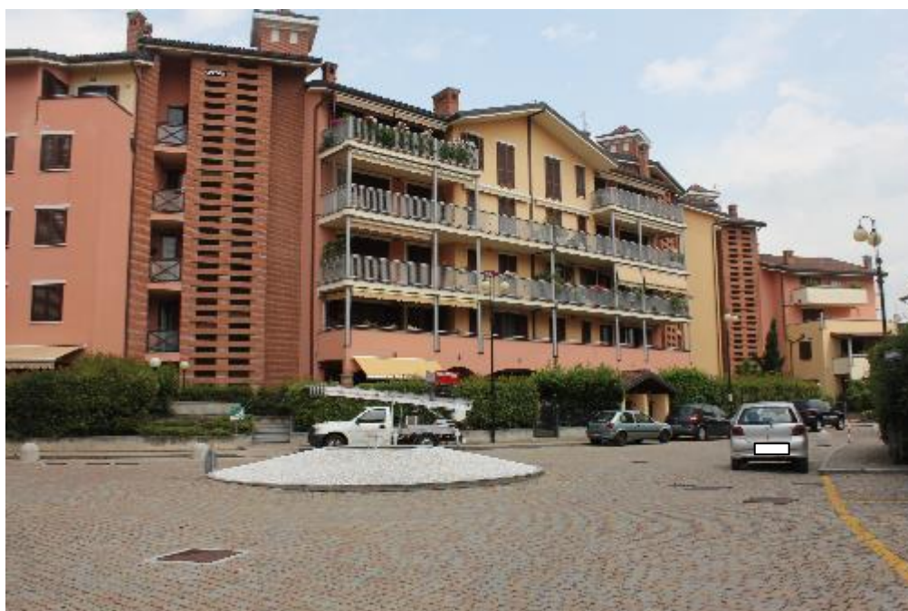
FOTO 2: TREZZANO S/N (MI), VIA MORONA 10, vista fabbricato da cortile condominiale
