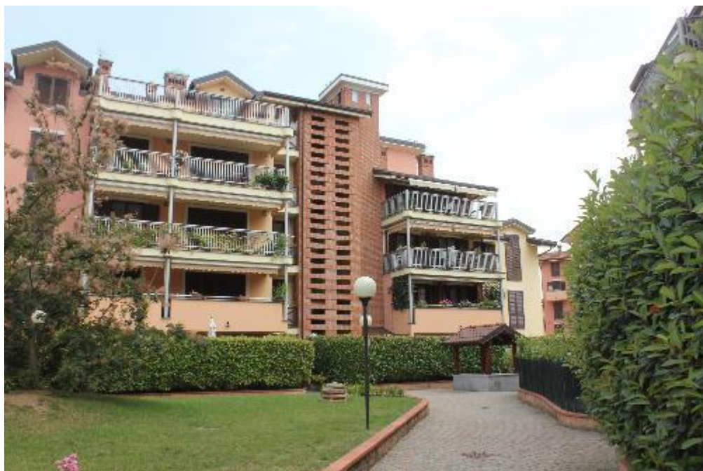
FOTO 3: TREZZANO S/N (MI), VIA MORONA 10, vista fabbricato dal cortile condominiale
