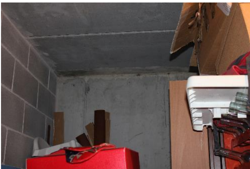
FOTO 26: TREZZANO S/N (MI), VIA MORONA 10, cantina
