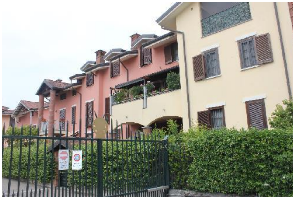
FOTO 1: TREZZANO S/N (MI), VIA MORONA 10, vista fabbricato da via Morona
