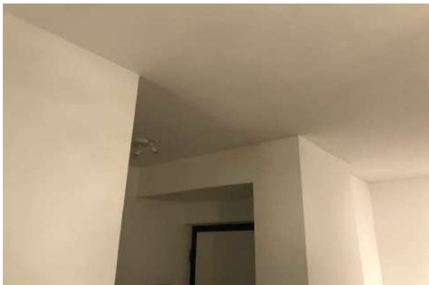
Foto n. 15-16: vista dei disimpegni: ingresso - zona notte.
