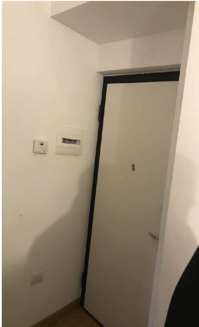
Foto n. 20: vista del portone di ingresso.
