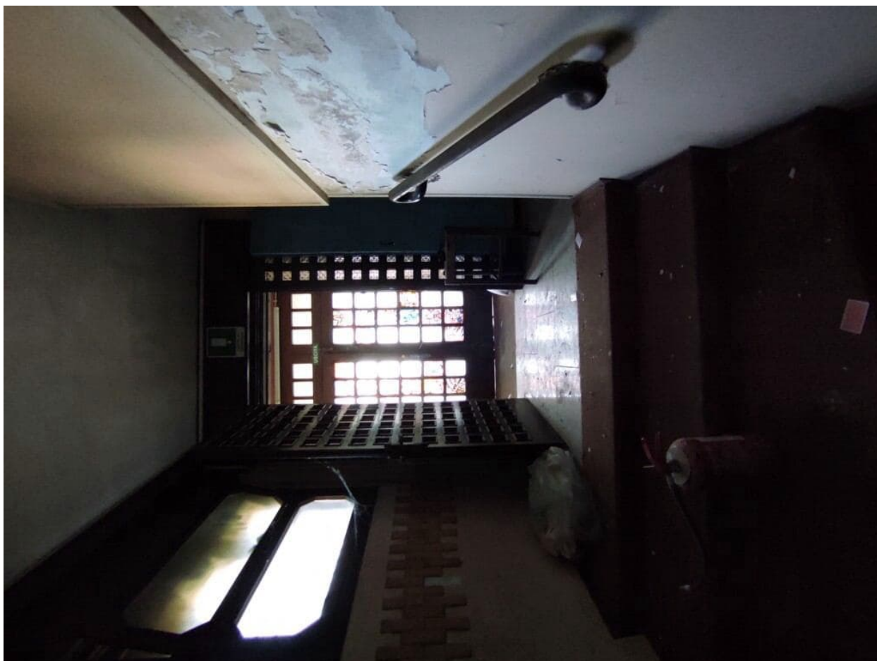
FOTO 46 Vano scala Piano Interrato.jpg
