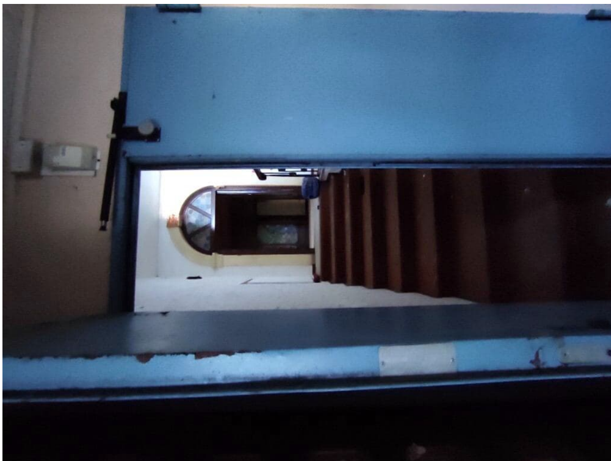
FOTO 45 Vano scala Piano Interrato.jpg
