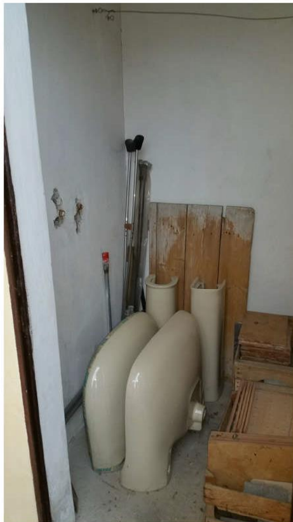
18-Lotto 1 - vano caldaia
