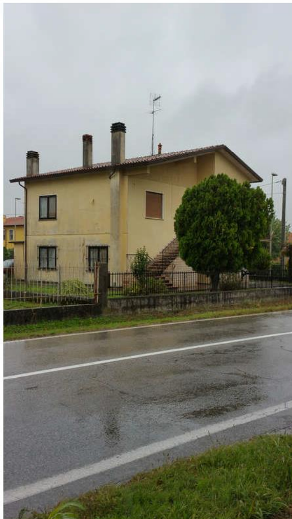
2-Esterni Lato da Via Levada
