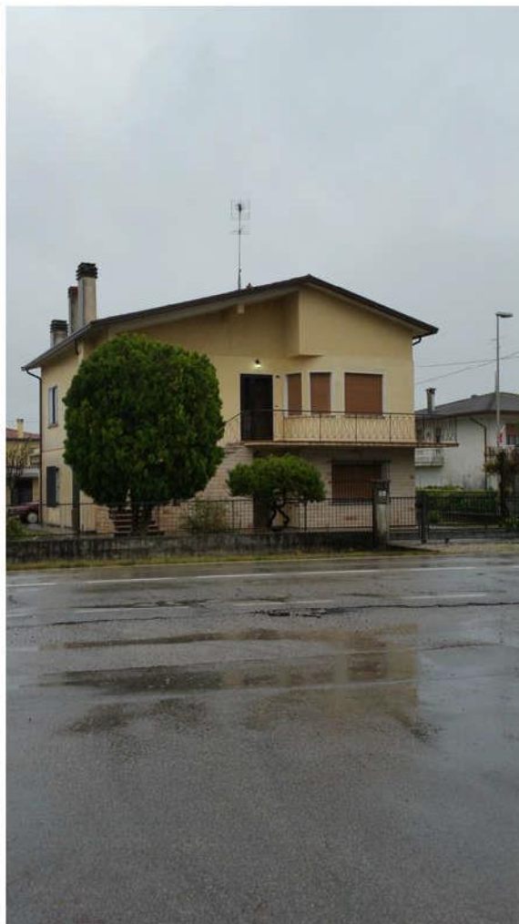
1-Esterni Fronte Via Levada
