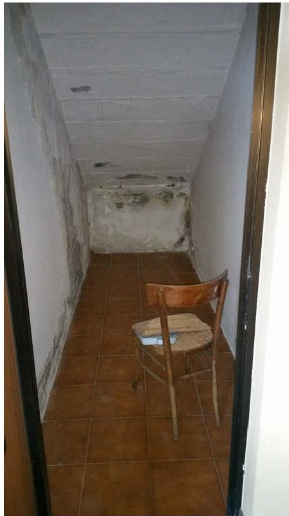
17-Lotto 1 - sottoscala esterno
