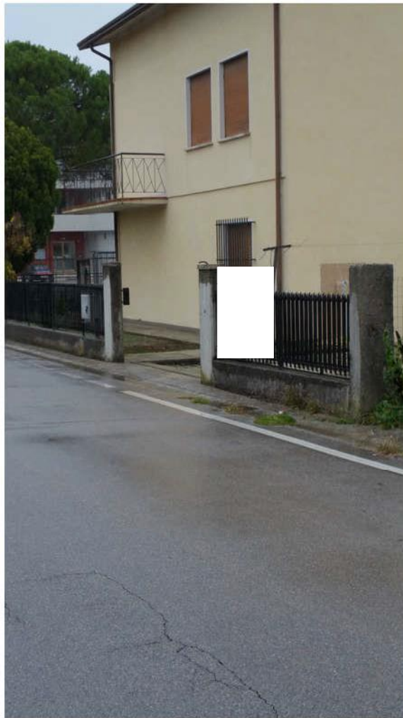
3-Esterni Lato Strada Laterale
