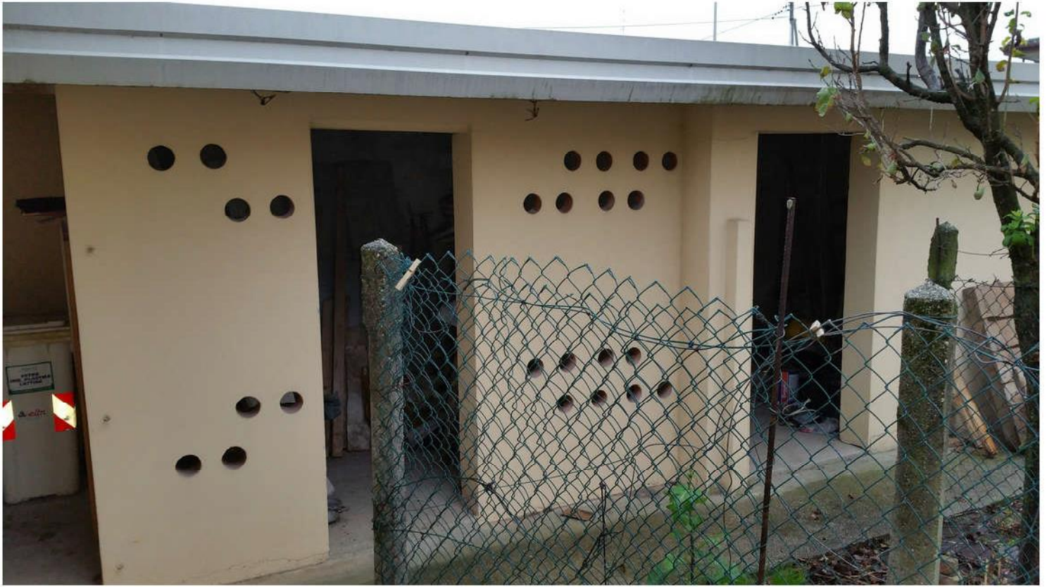
5-Esterni - Ripostigli lotto 1
