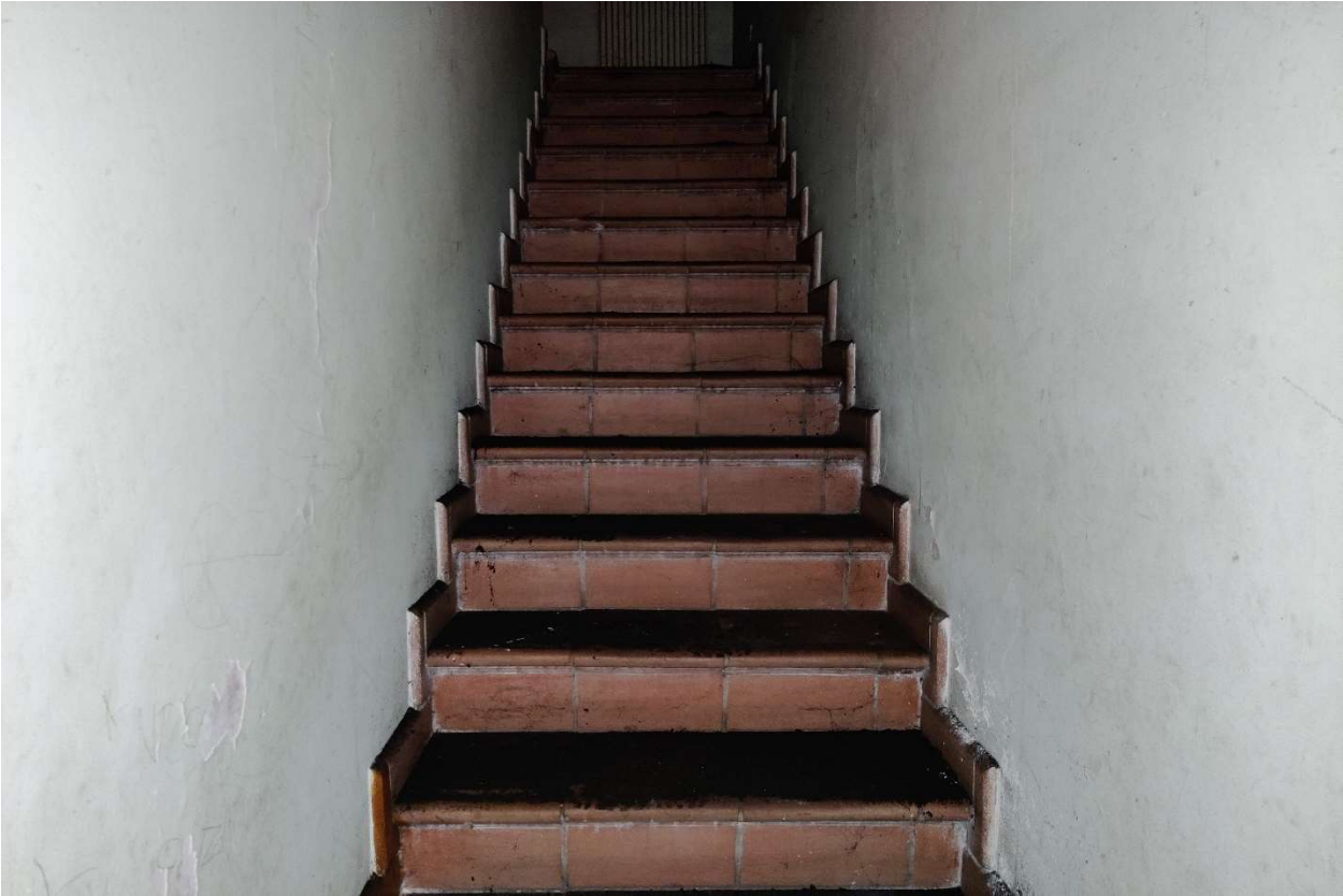
Foto n. 11 – Rampa di scale che conducono al piano.
