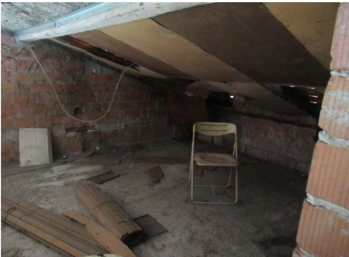
Foto 14: Soffitta angolo Sud-Ovest
