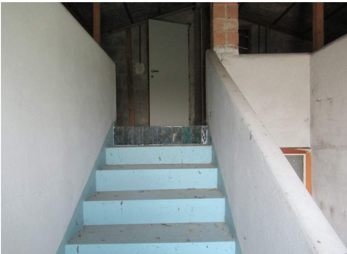
Foto 12: Scala collegamento alla soffitta
