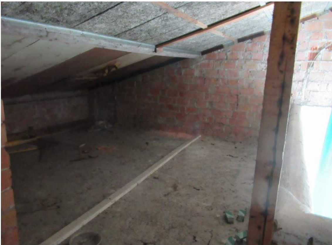
Foto 13: Soffitta angolo Nord-Est
