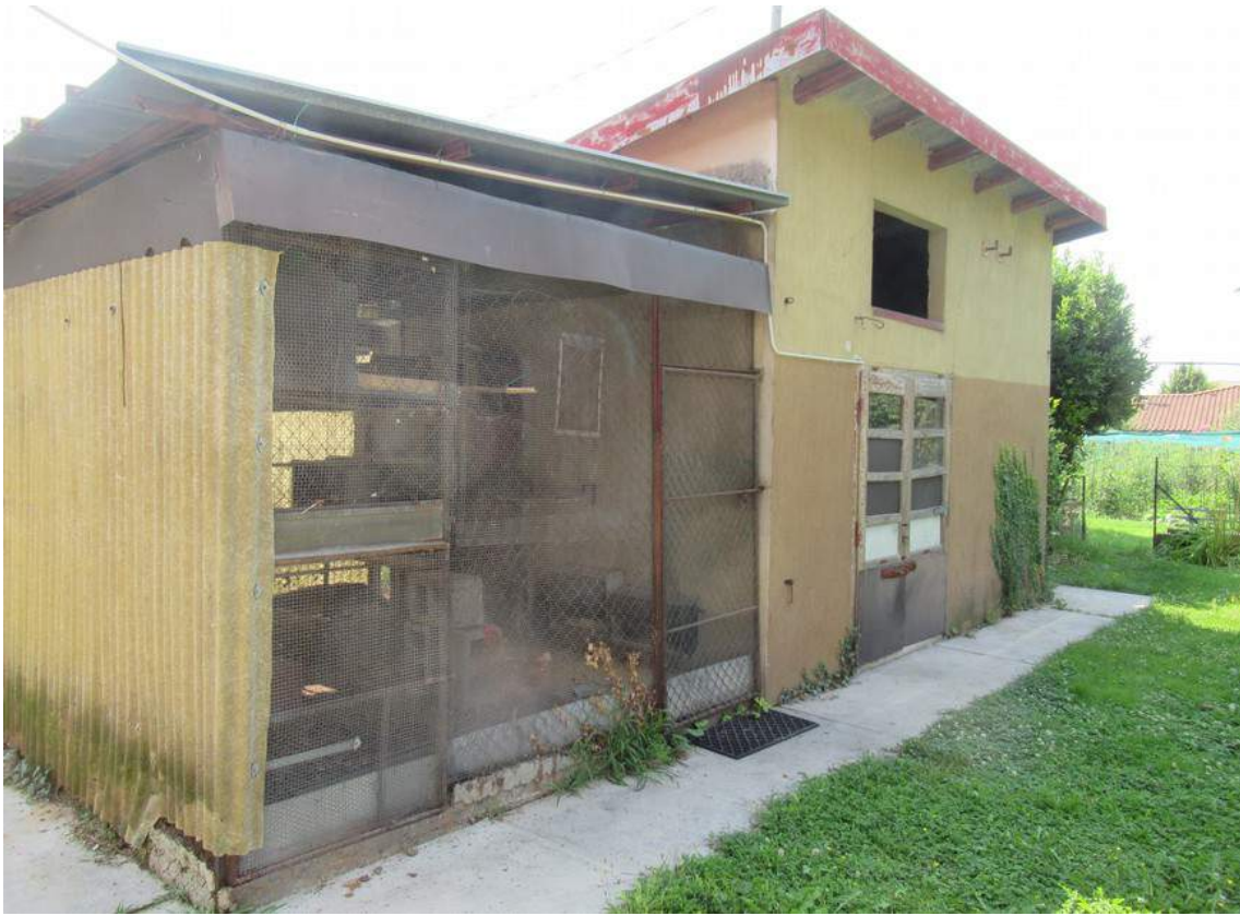
Foto 15: Vista tettoia e ripostiglio
