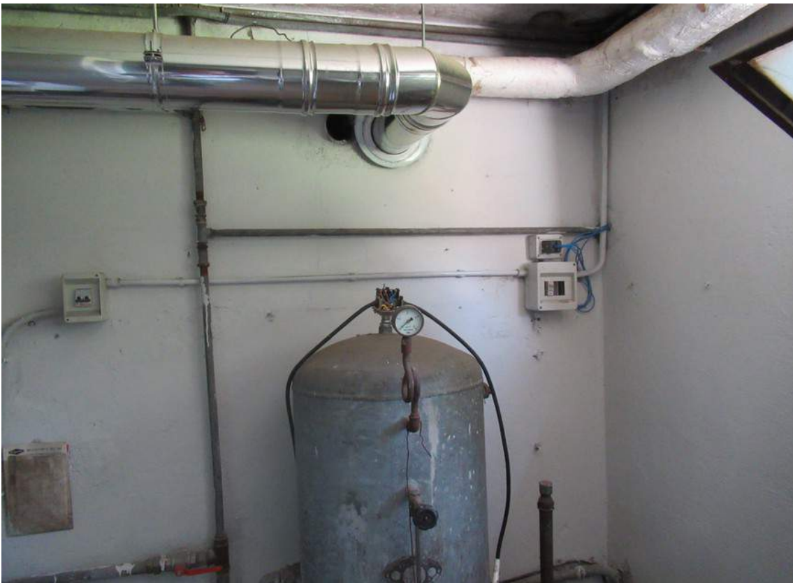
Foto 4: Ripostiglio piano scantinato
