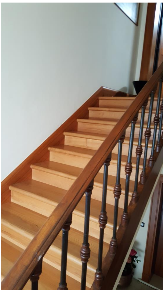
SCALA CONDOMINIALE DA 2° P. a 3° P.
