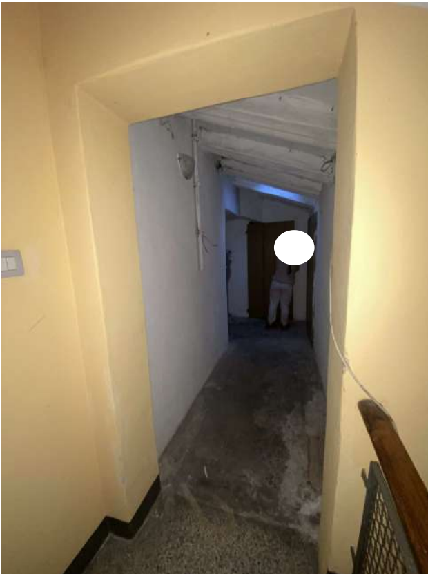
FOTO 16: Accesso locale nel sottotetto
