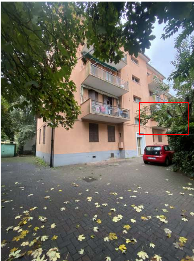
FOTO 4: Vista esterna fabbricato
