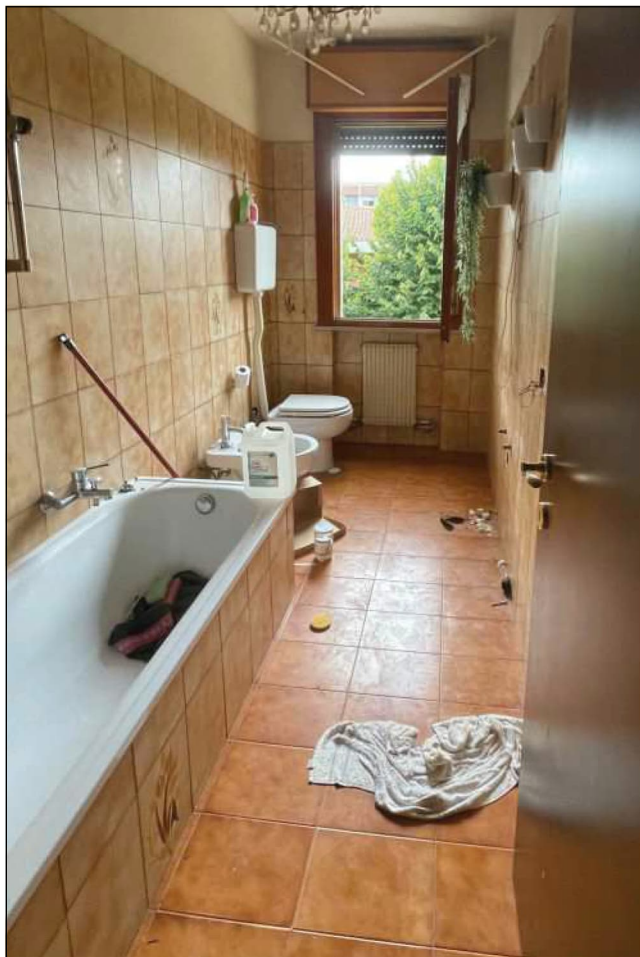
Foto n. 13) Vista del bagno ad ovest
