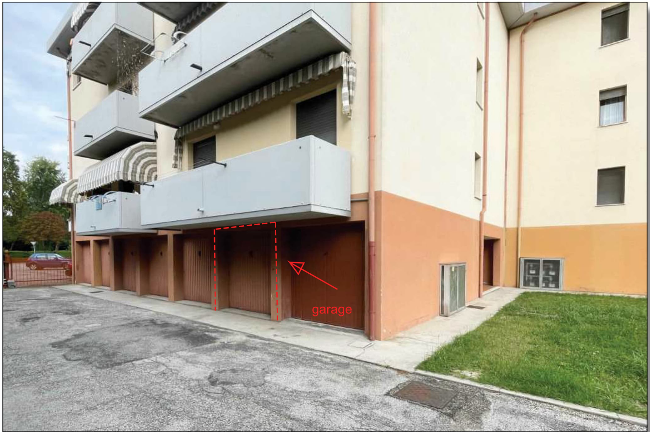
Foto n. 5) Vista del garage ad ovest
