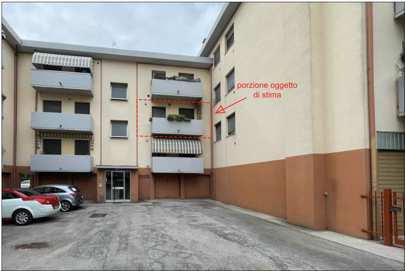
Foto n. 3) Vista del prospetto est con ingresso al vano scale
