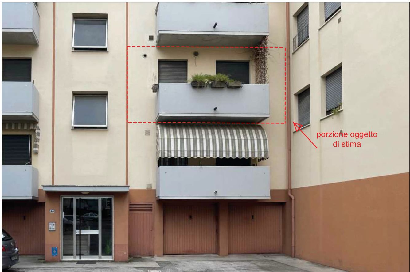
Foto n. 4) Vista del prospetto est con ingresso al vano scale
