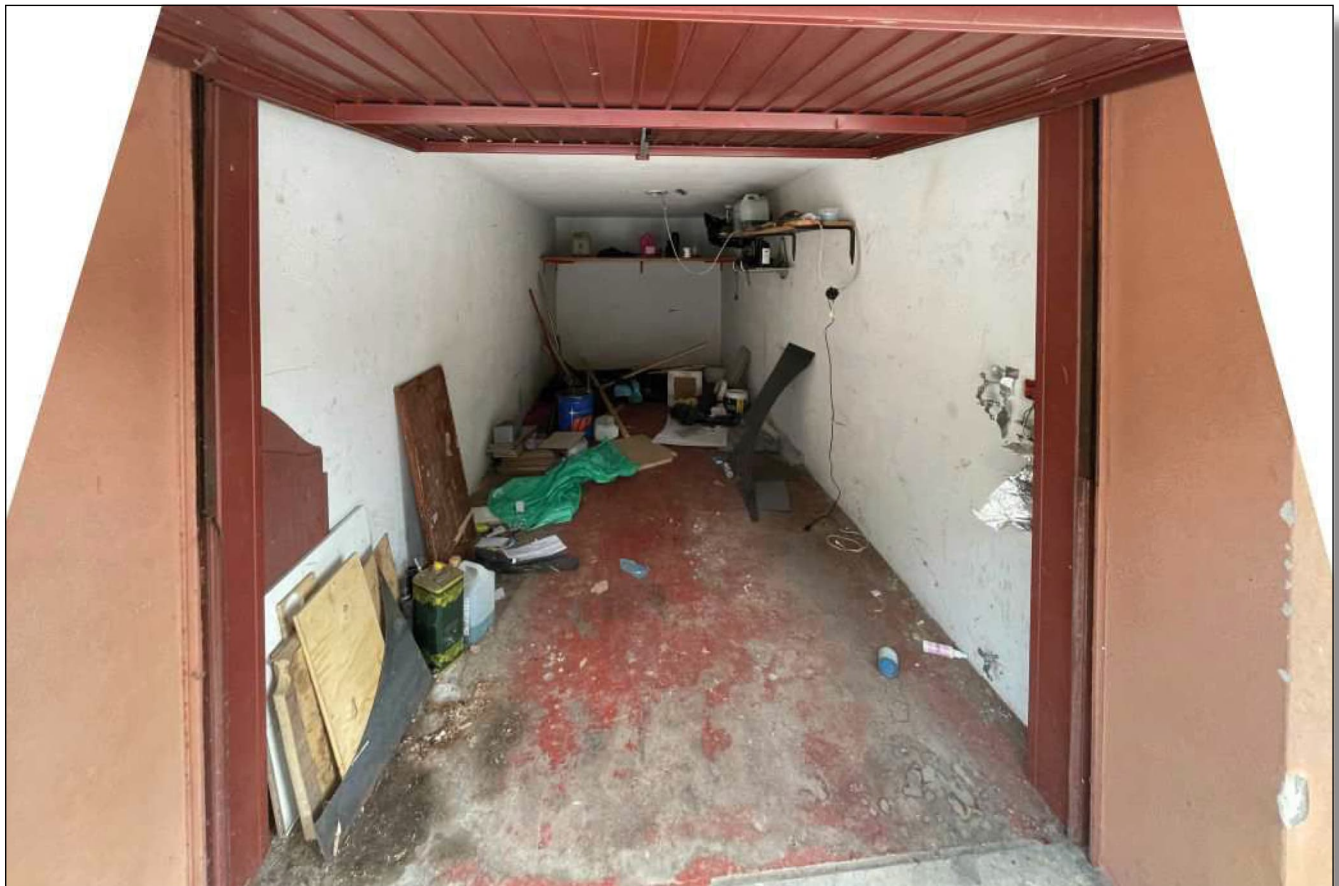
Foto n. 6) Vista interna del garage
