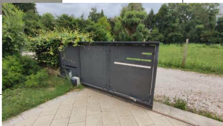
Lato nord – ingresso carraio
