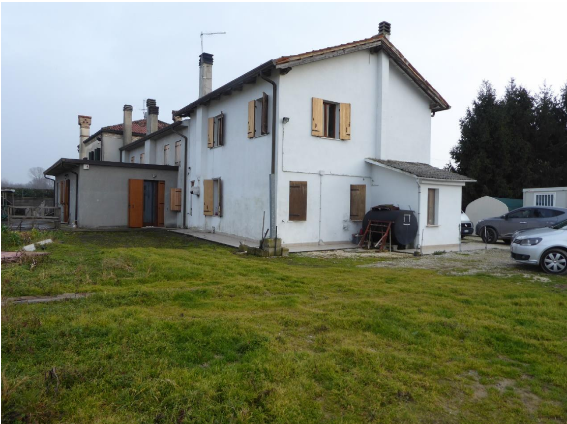
Immagine n. 5 Vista esterna immobile oggetto di stima (porzione di fabbricato)
