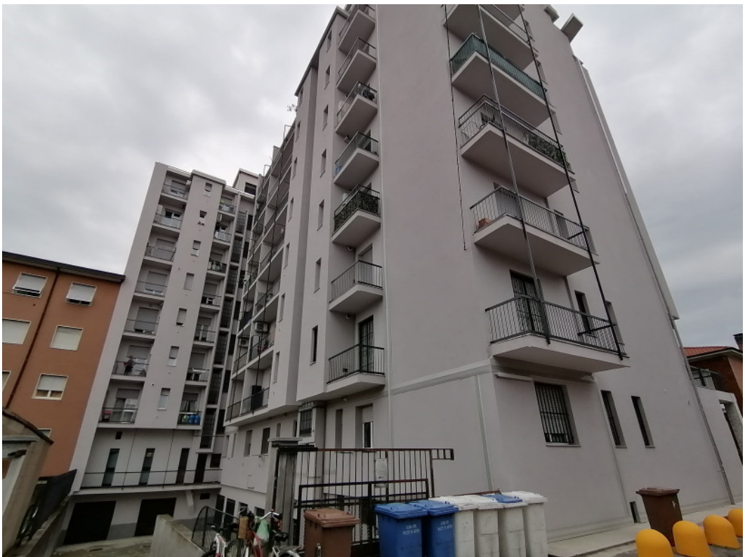
FACCIATA POSTERIORE SU VIA PRIVATA
