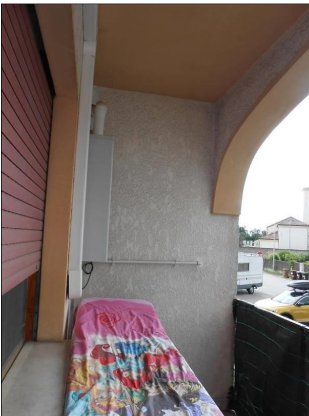
41) 42) Vedute della loggia
