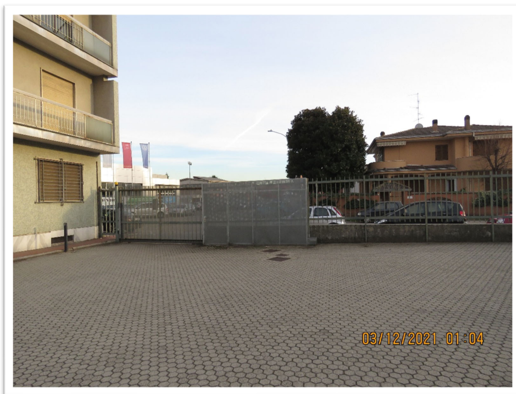
L'area esterna con il fabbricato delle autorimesse.
