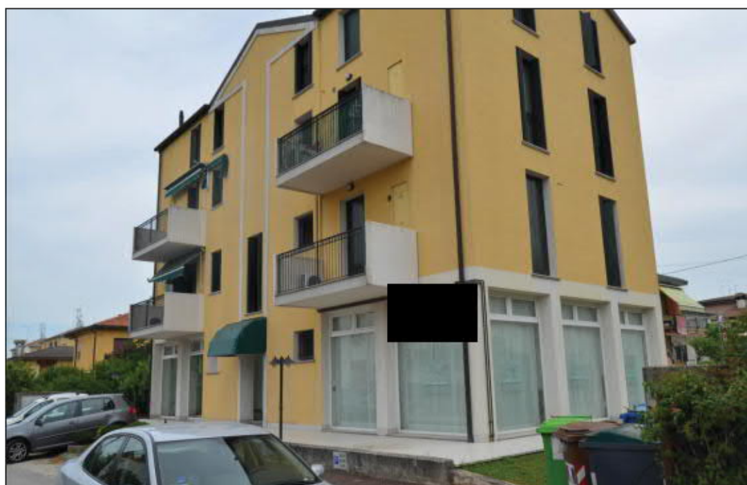
foto n. 6 : vista del condominio da via De Gasperi
