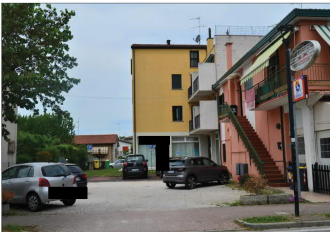
foto n° 5: vista del condominio da via Stazione
