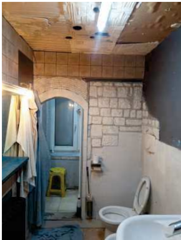
Interno – Foto 18_Bagno
