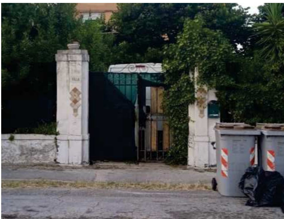
Esterno – Foto 4 _Accesso carrabile da via Flaminia
