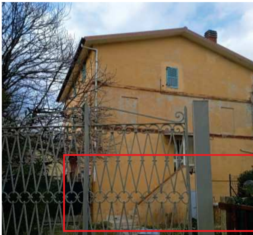
Esterno – Foto 3 _vista lato Sud-Est
