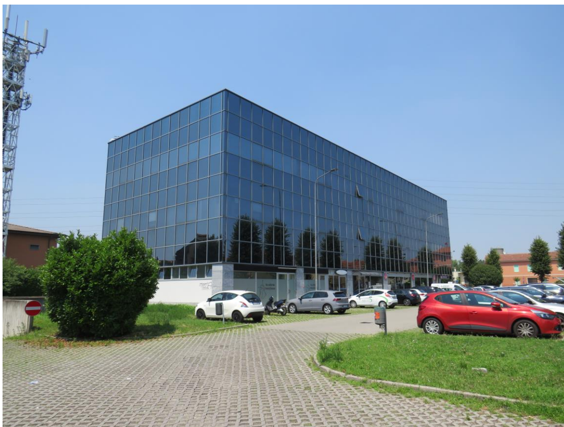
FACCIATA SU VIA MAZZINI
