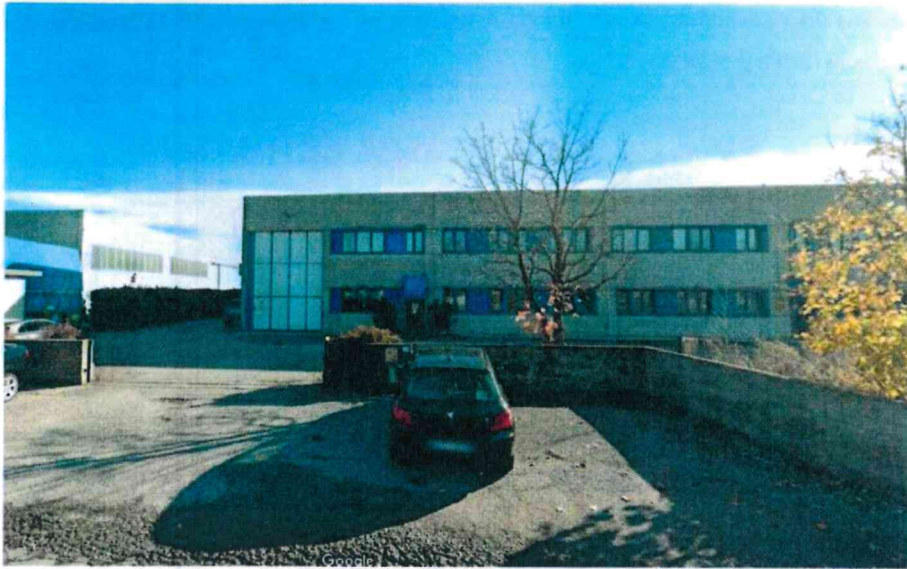
3. Foto: localizzazione degli immobili – Fronte strada
