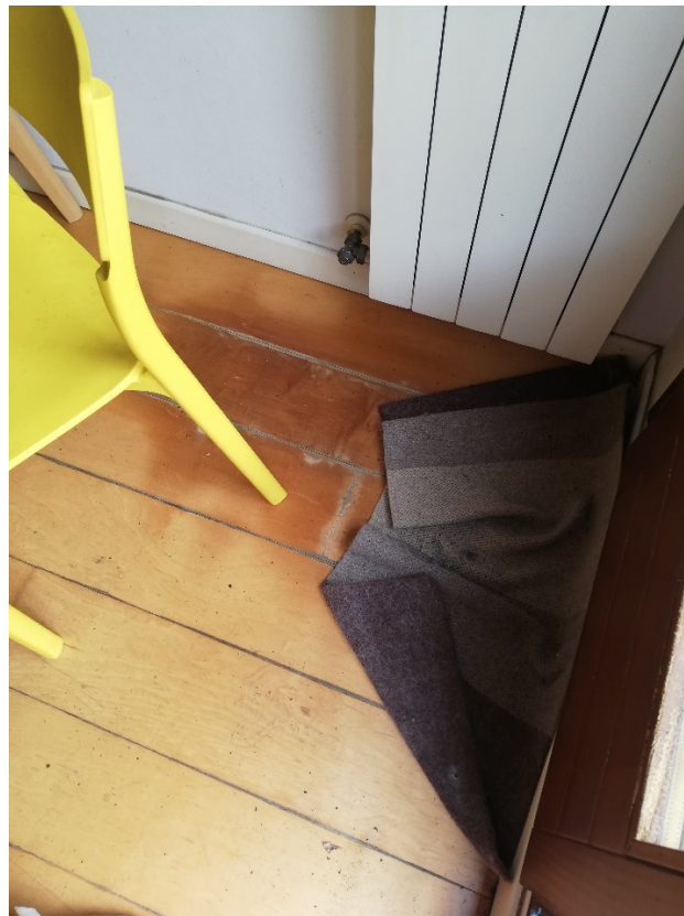
Foton.14: particolare del pavimento posto in cucina
