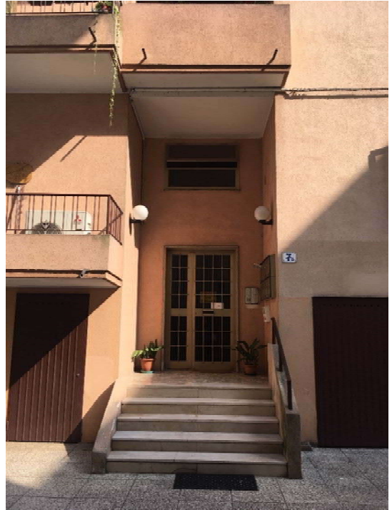
Foto n. 3 e 4: vista fabbricato lato sud e particolare 5° piano
