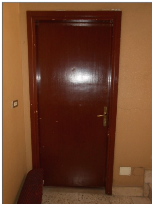
Foto 4 porta ingresso all'immobile
