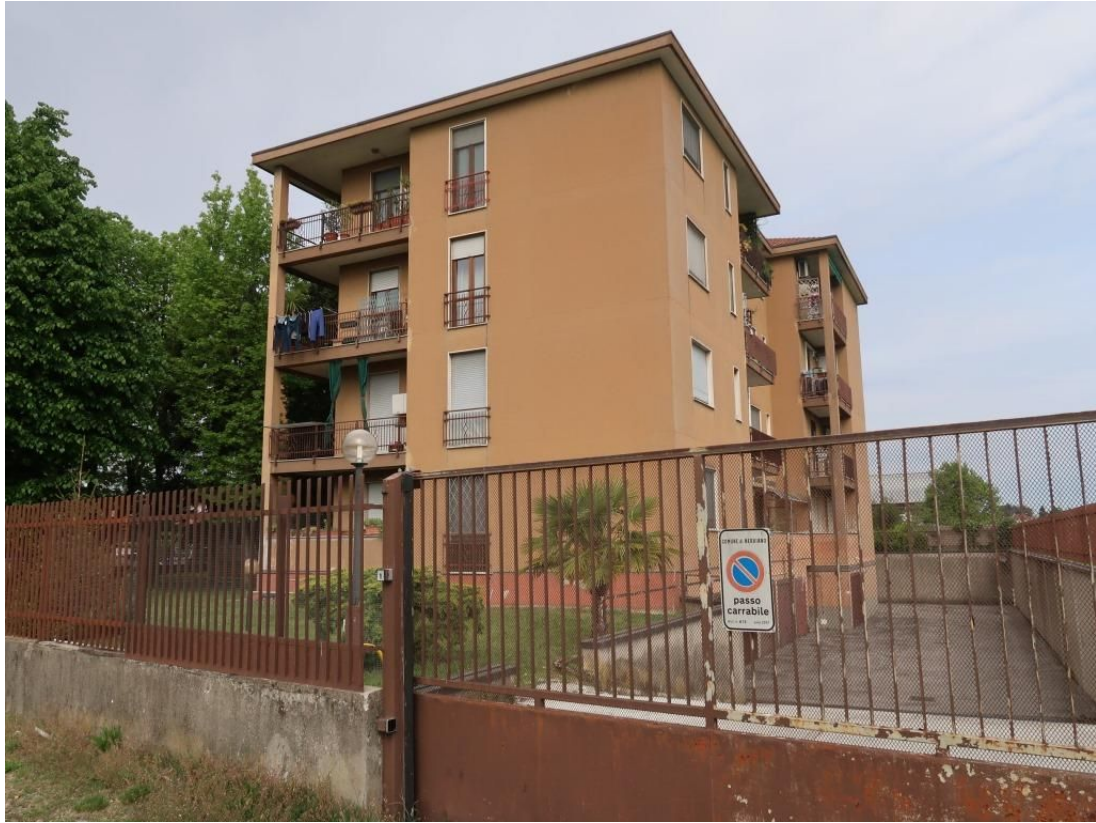
FACCIATA CON INGRESSO CARRAIO
