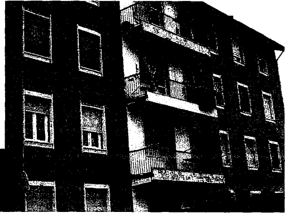
Vista fronte posteriore
