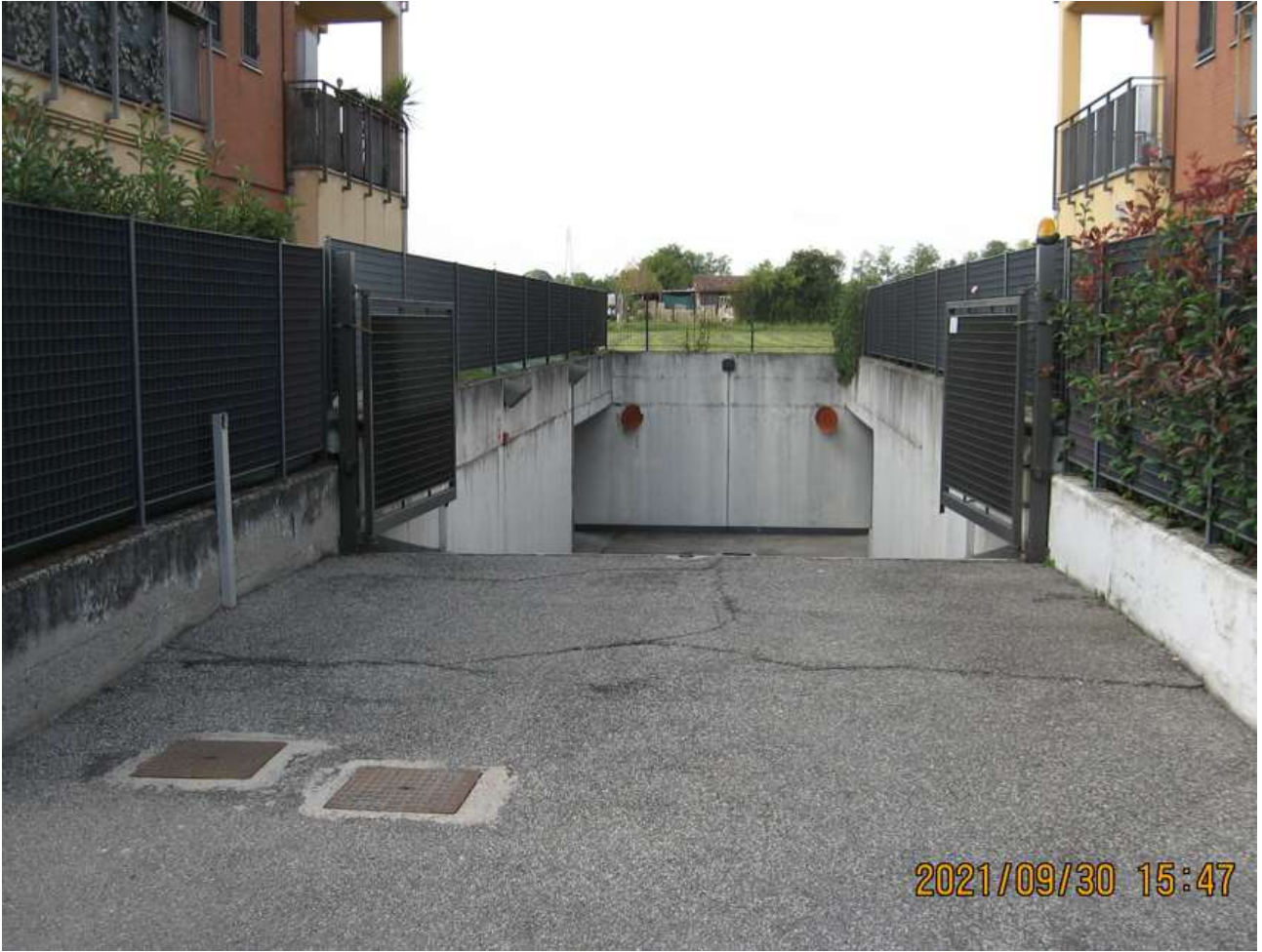
Rampa di accesso al box
