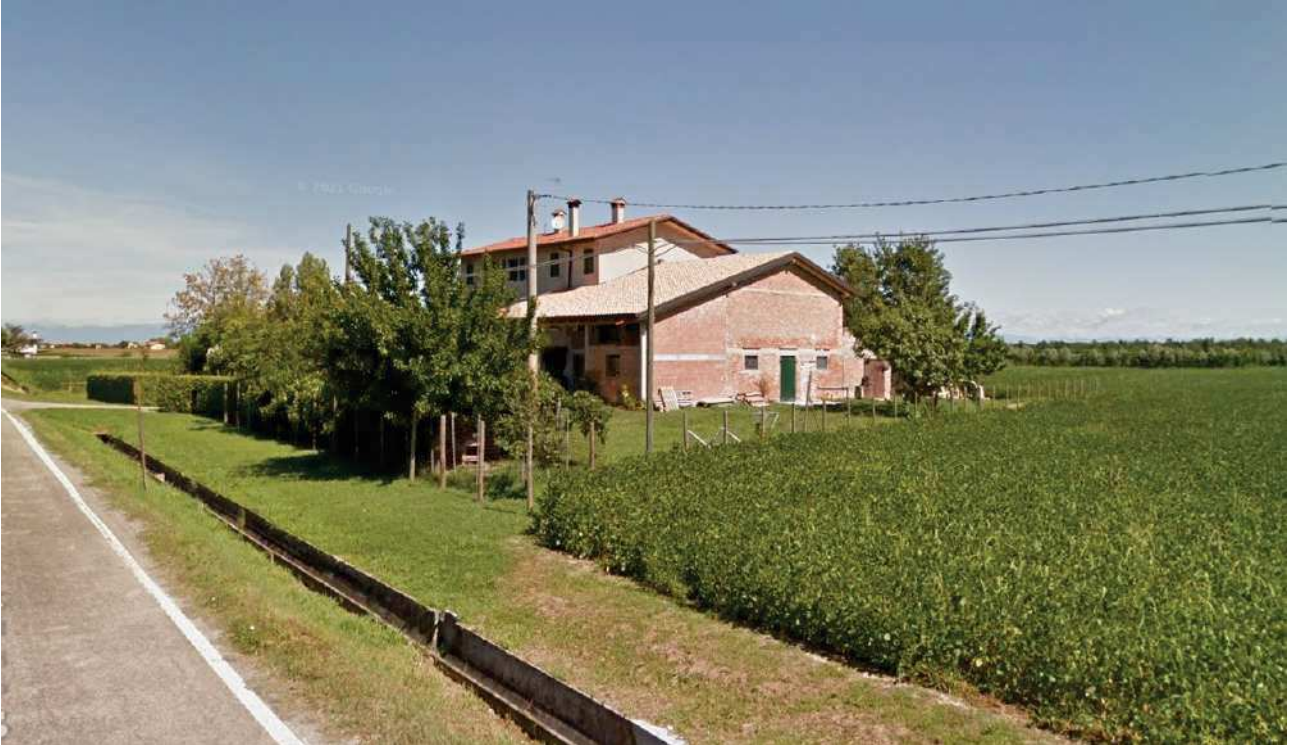
Vista del fabbricato da Est
