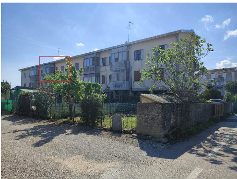
Foto n. 2 Vista da Nord-Est, da Via Marco Polo
