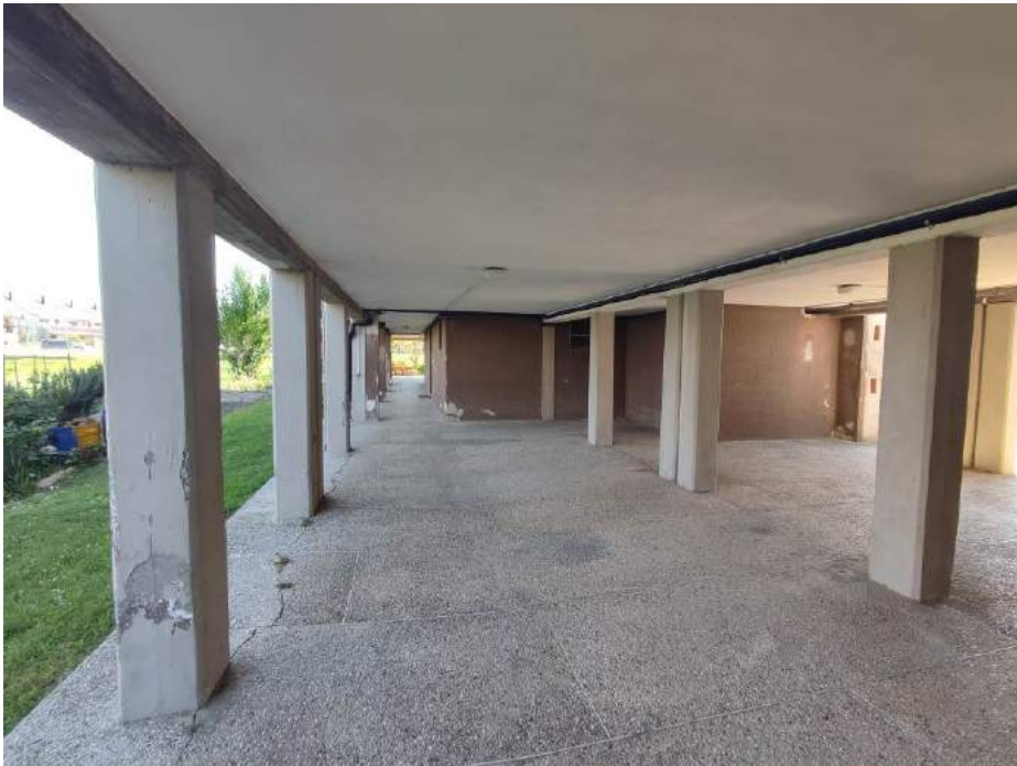
Foto n. 6 Vista da Nord su Portico Comune
