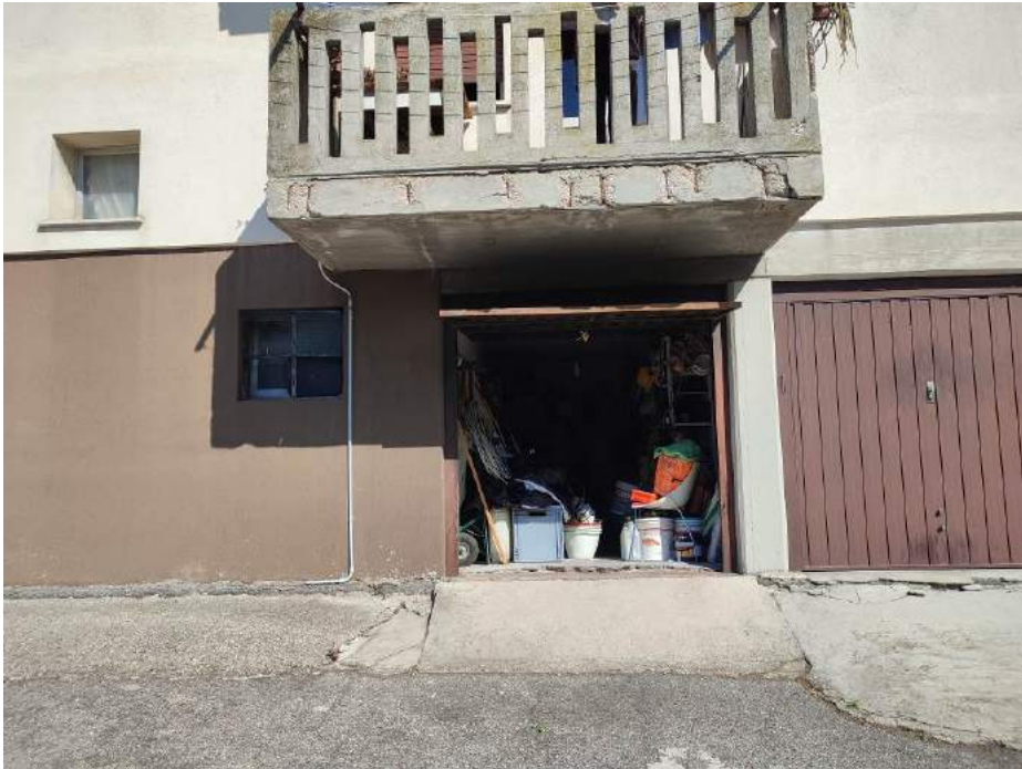
Foto n. 5 Vista da Ovest su Garage
