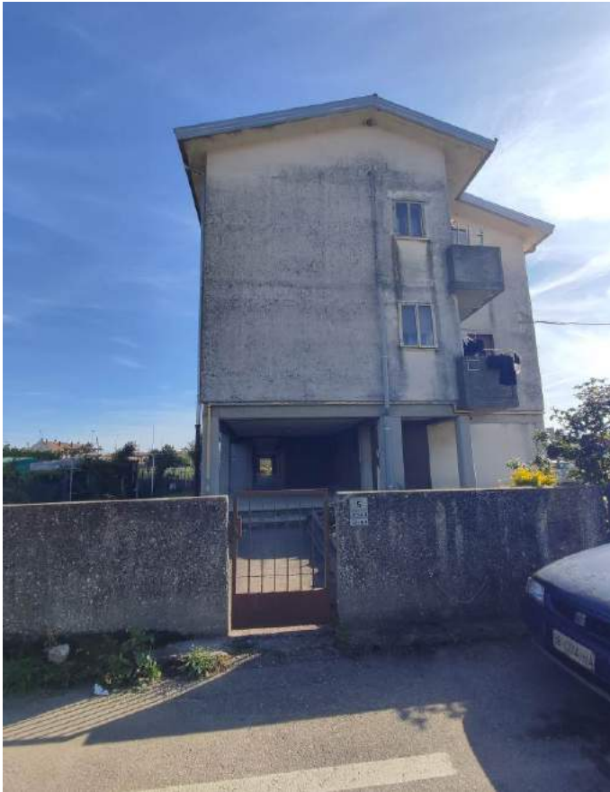
Foto n. 3 Vista da Nord, da Via Marco Polo
