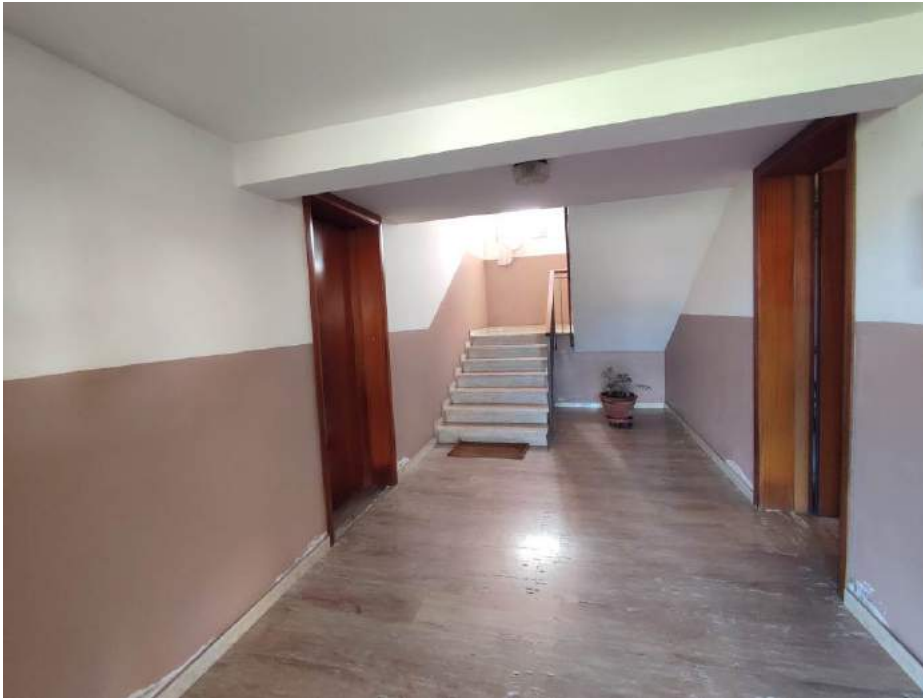
Foto n. 7 Vista su vano scala condominiale
