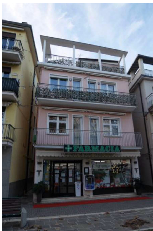
FOTO 1 - Il fabbricato in Via San Marco 629.
