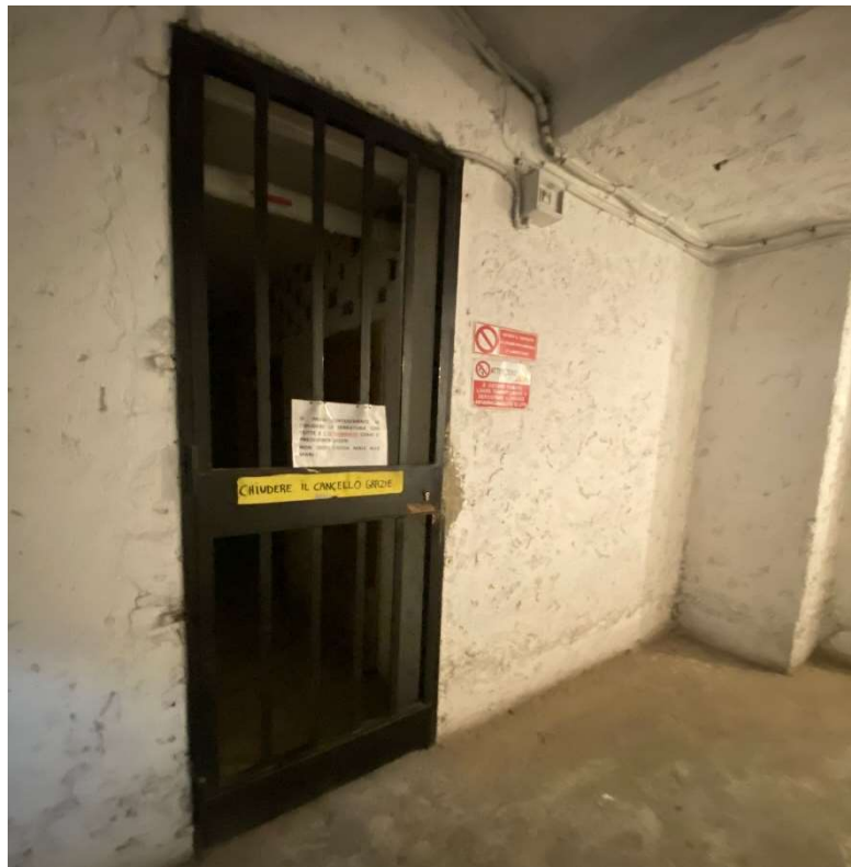
Foto n. 9 – ingresso alle cantine
