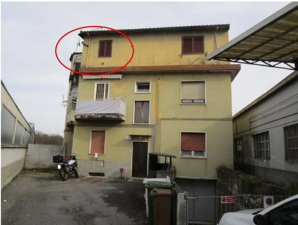
Foto 2 – Vista del complesso condominiale in cui è ubicata l'unità immobiliare
